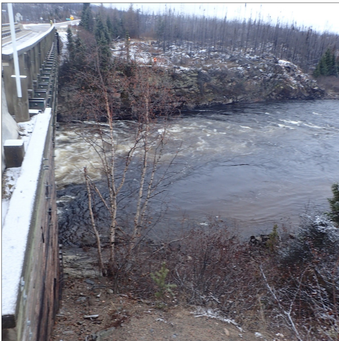
Photo 1 : Projet 154-13-0962, zone d'intervention avec rive sud-ouest en arrière-plan
