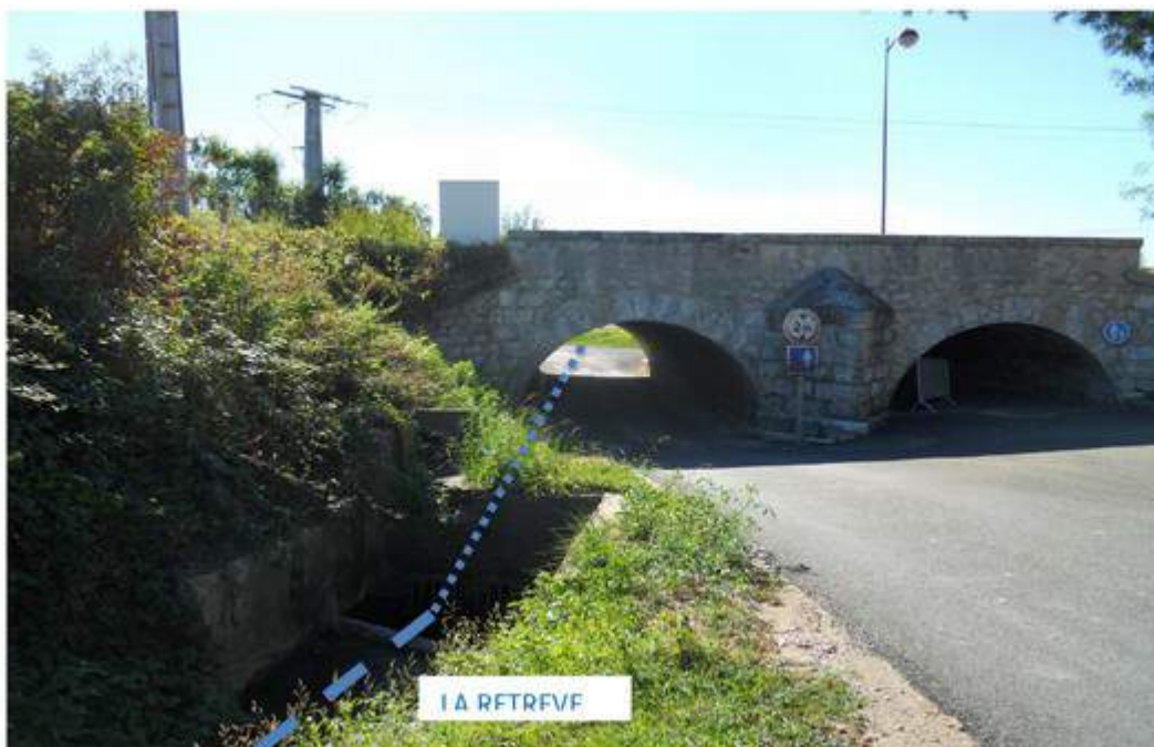
Figure n°7 – Ouvrage RD 2020 à l'amont – Source COFIROUTE
