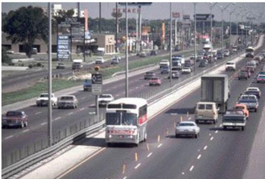
Figure 5. Voie réservée à contre-traffic
