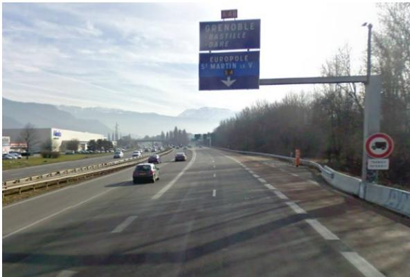
Figure 7. Voie d'autobus sur le côté droit d'une autoroute près de Grenoble
