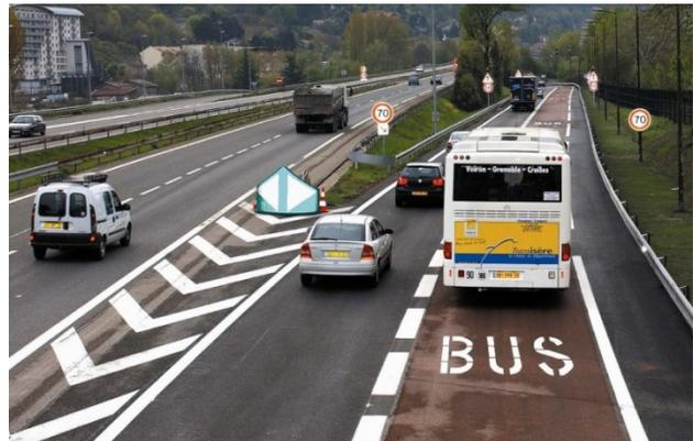
Figure 8. Voie d'autobus sur le côté droit de la sortie d'une autoroute près de Grenoble
