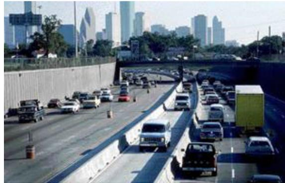
Figure 4. Voie réservée avec séparation de barrières
