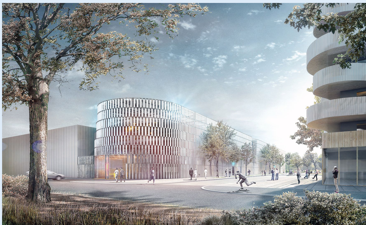
Centrale de mobilité de l'EcoQuartier fluvial de l'Île Saint Denis.
