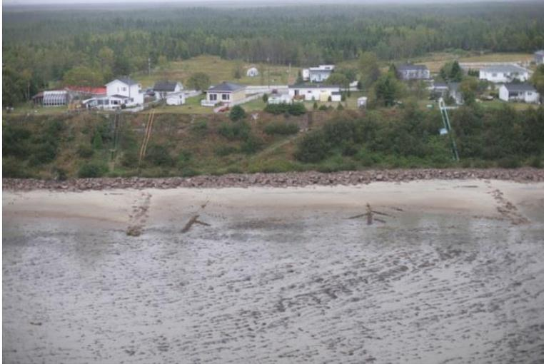
Figure 246. Exemple d'épis Maltais-Savard combinés à des épis rocheux et à un enrochement linéaire
