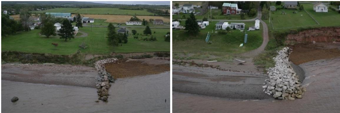
**Figure 244. Effet d'un épi lorsque l'apport sédimentaire est faible : accumulation en amont de la dérive littorale et érosion en aval, Caplan, 2010. Source : LDGIZC, UQAR**
