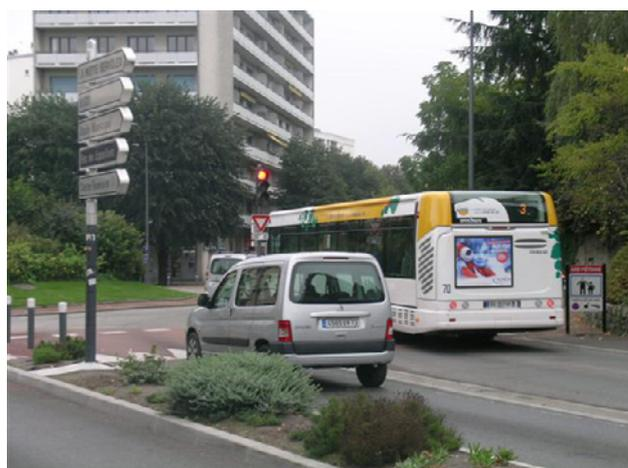
Implantation du signal R22j sur la branche dotée de site propre ; sur l'autre branche, le bus est dans la circulation générale et il n'y a donc pas de signal R22j.
