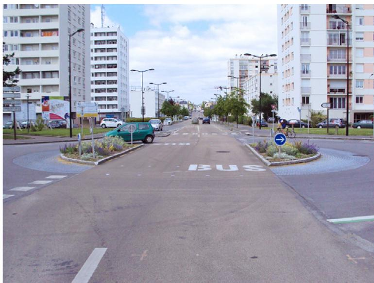
*Carrefour en fin de site propre : le cédez-le-passage sur l'anneau donne la priorité au bus s'insérant en site banal en sortie du carrefour.*
