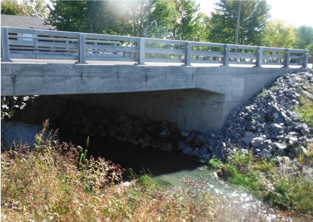
**Figure 1 Exemple d'enrochement réalisé pour protéger un pont (17536)**
