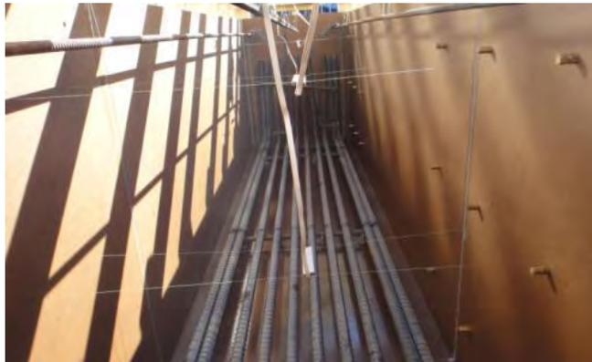
Figure 50 : Jauges noyées et ancrages pour les plots dans les parois du coffrage (coffrage de la série no. 1).
