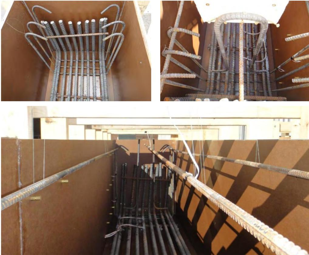
Figure 146 : Cage d'armature positionnée à l'intérieur du coffrage.
