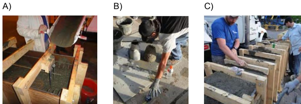
Figure 148 : Mise en place du béton dans les coffrages (A). Essais sur béton frais (B). Finition des dalles épaisses (C).
