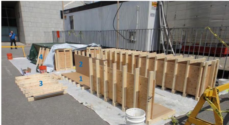
Figure 141 : Assemblage des coffrages.
