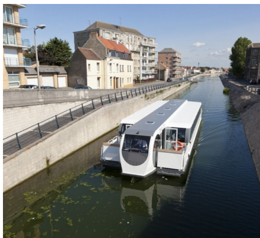
Aménagement des berges du canal de Calais Source SITAC - Photo : Olivier Leclercq
