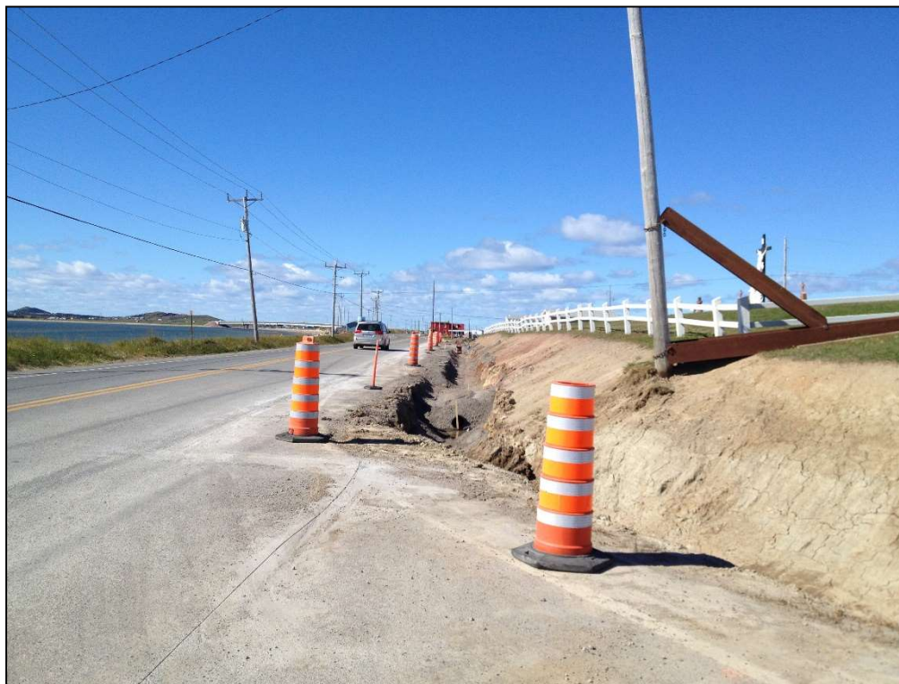
Photo 6 : Projet n° 154-88-0081, site CiCk-3, opération 1, tranchée excavée, vers le nord-ouest (photo n° 154-88-0081-111).
