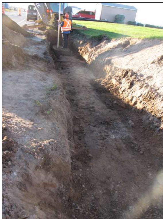
Photo 1 : Projet n° 154-88-0081, site CiCk-3, sous-opération 1B, excavation en cours, vers le nord-ouest (photo n° 154-88-0081-015).
