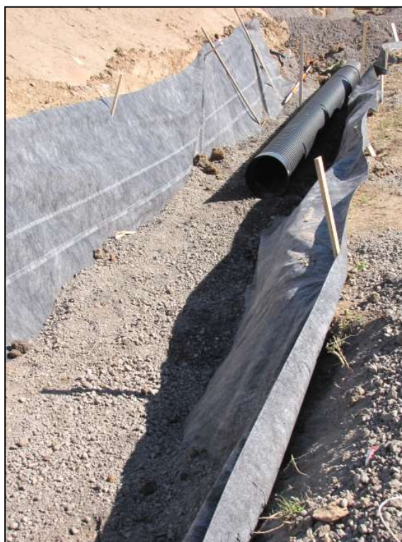
Photo 3 : Projet n° 154-88-0081, site CiCk-3, opération 1, mise en place des équipements du MTQ, vers l'est (photo n° 154-88-0081-094).
