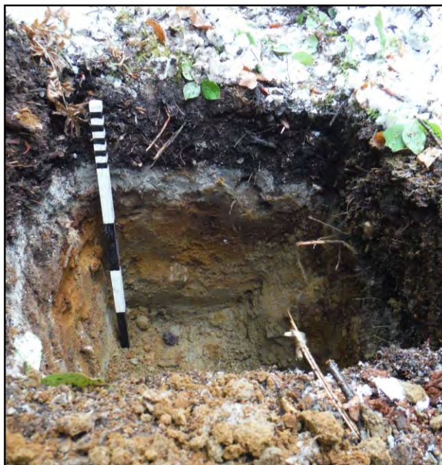
Photo 11 Séquence stratigraphique podzolique observée dans le secteur 2 (chaînage 5+440), vers le nord (DUCD-13-0178-045)
