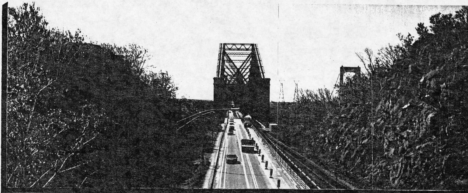
Figure 20 Secteur de l'Aquarium / Pont de Québec
