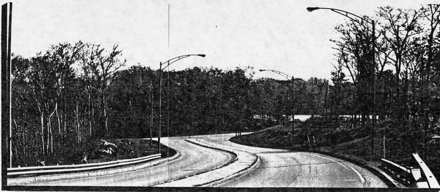
Figure 21 Secteur de l'Aquarium / Pont de Québec
