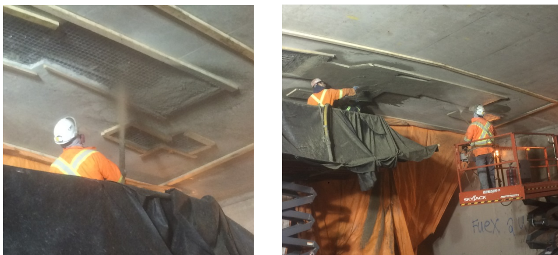
Figure 3: Projection de la surface à réparer (gauche); finition en cours (droite).
