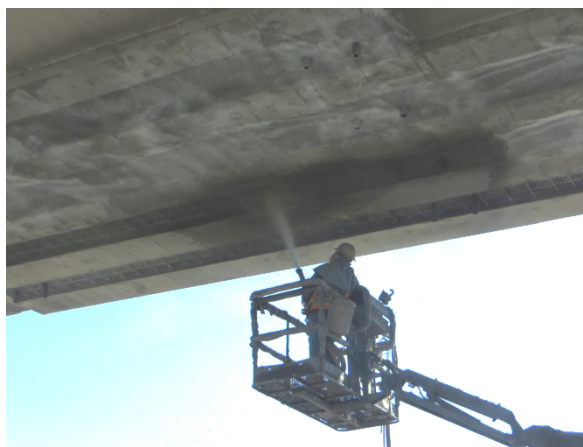
Figure 1: Projection de la dalle évidée (gauche) et de la portion (AH) de l'ouvrage. Notons la finition en arrière-plan à la truelle rotative.
