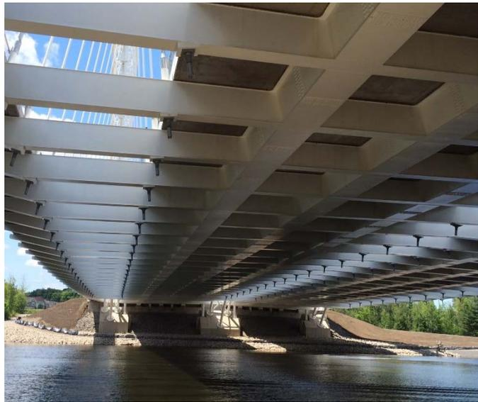
**Vue de la charpente métallique sous le tablier**
