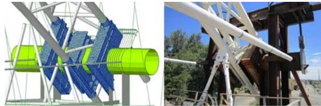
Poutre de transfert provisoire – Modèle numérique et structure réelle
