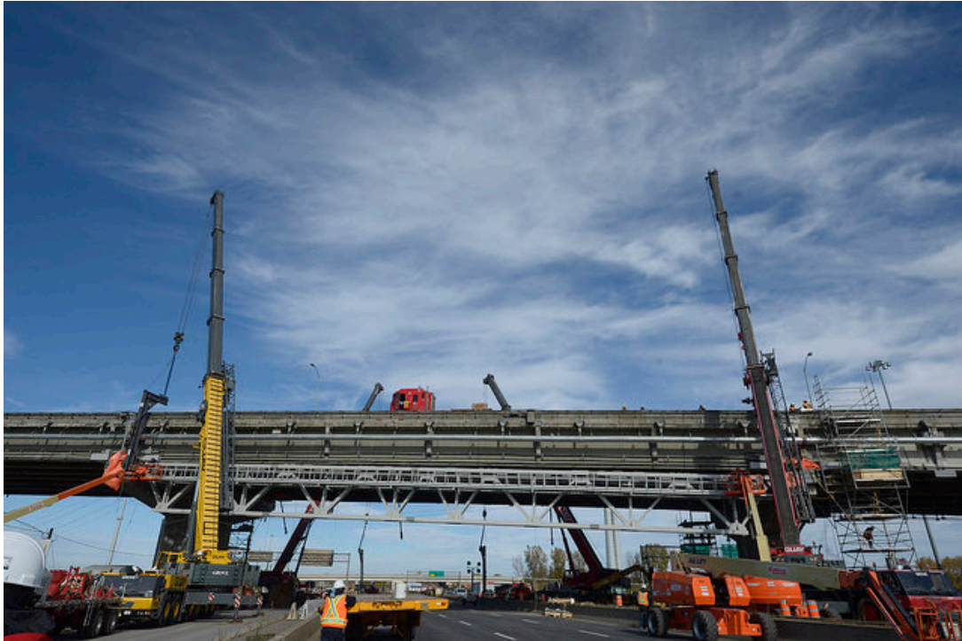
Image 8 : PJCCI a procédé à l'installation de treillis modulaires sur les poutres P1 et P7 de la travée 10E-11E du pont Champlain durant la fin de semaine du 24 et 25 octobre 2015
