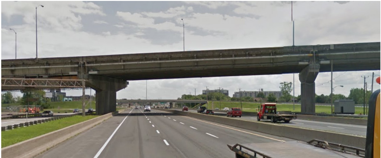
Image 6 : Travée 10E-11E de la section 7 du pont Champlain qui enjambe la route 132 (source : Google Street View – juin 2015)
