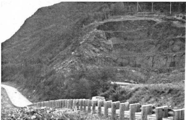
Destructuration du paysage par l'exploitation d'une carrière en bordure de la route 132.
