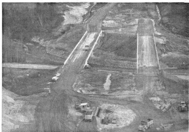
Construction de l'autoroute 40 entre Trois-Rivières et Québec
