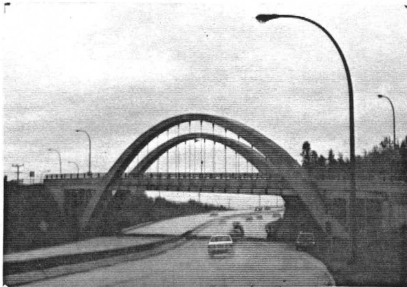
Viaduc sur l'autoroute 15 - le design du mobilier fait partie de l'environnement visuel.
