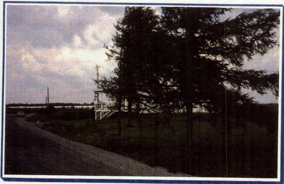
PHOTO 17 Vue amont du retrait d'emprise montré à la figure 17
