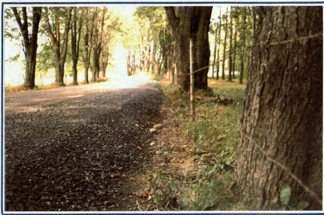
PHOTO 26 Protection des arbres à l'intérieur d'un tunnel végétal en dégageant la base des arbres lors du rechargement
