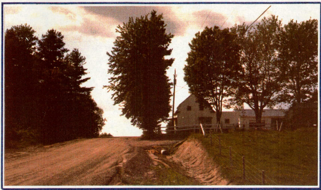
PHOTO 4 Utilisation d'un point haut naturel pour éviter l'expropriation d'une maison et conserver le cadre environnemental de la propriété
