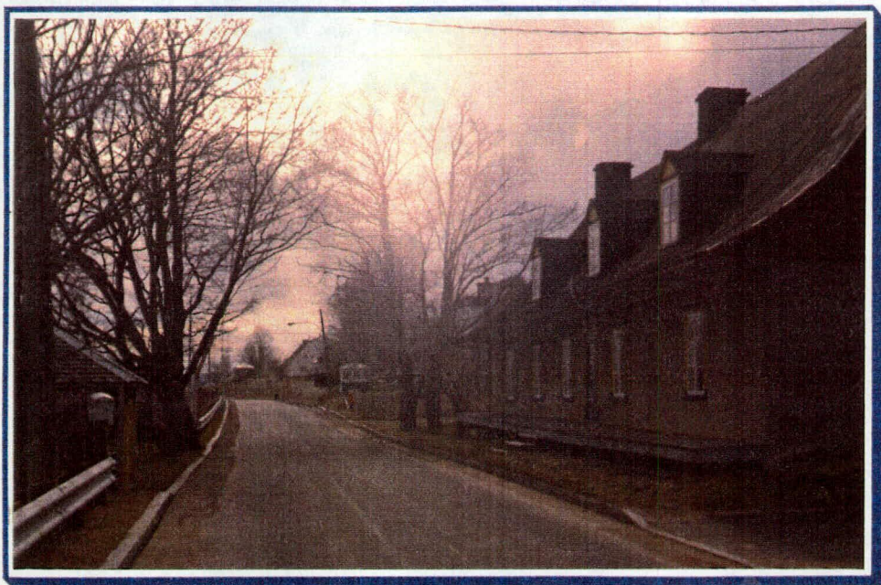
PHOTO 23 Section réduite à 5,5 mètres
