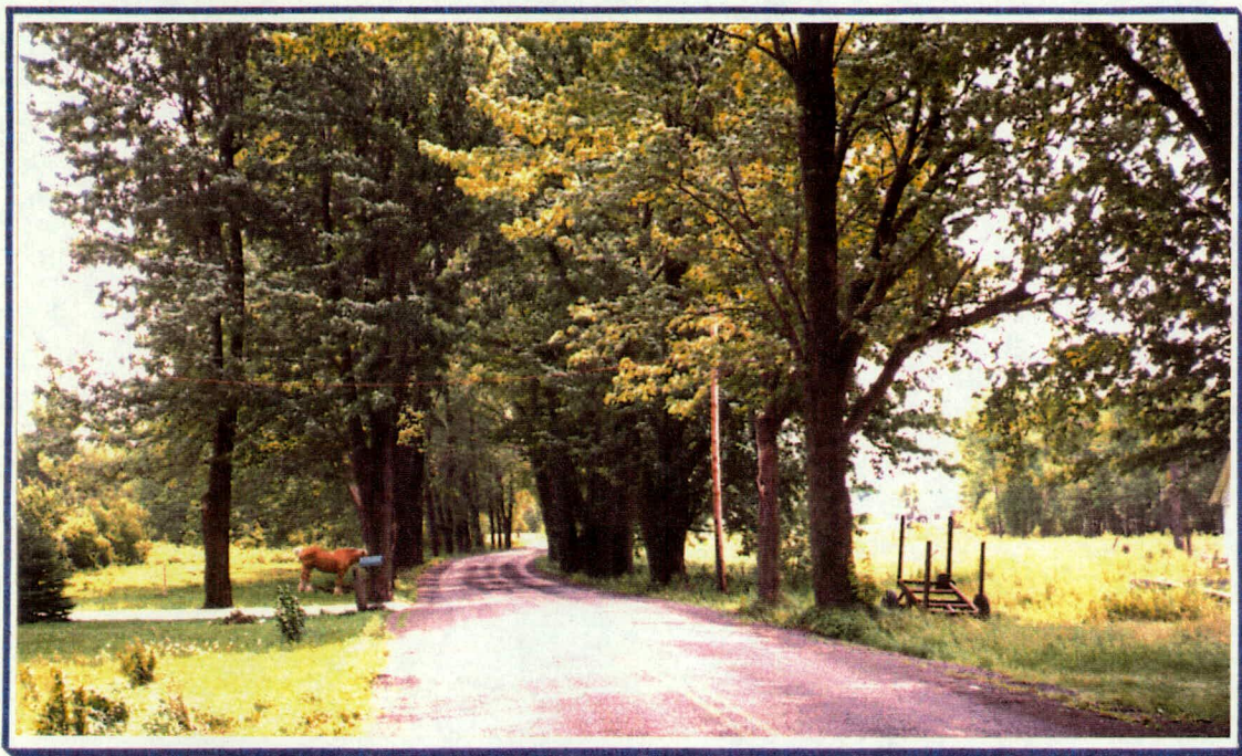
PHOTO 28 Même tunnel végétal après qu'il ait reçu un double traitement de surface
