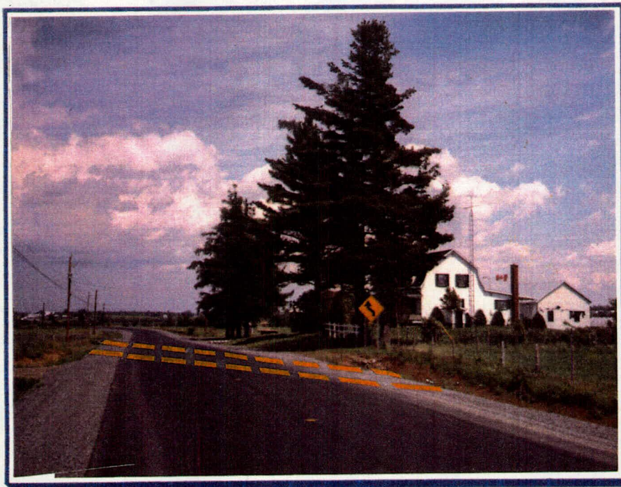
PHOTO 5 Transfert de drainage pour éviter d'endommager les racines d'une rangée de pins matures
