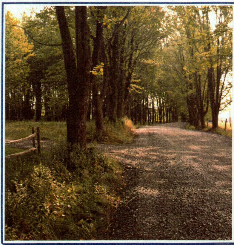
PHOTO 27 Protection des arbres à l'intérieur d'un tunnel végétal en dégageant la base des arbres lors du rechargement
