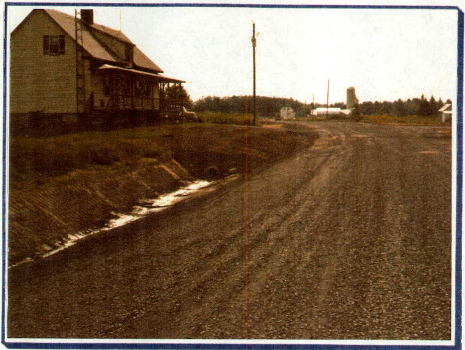
PHOTO 10 Drainage fermé aménagé devant une propriété
