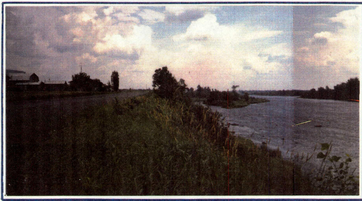
PHOTO 6 L'axe central de la route a été déplacé pour éviter le rapprochement d'un cours d'eau
