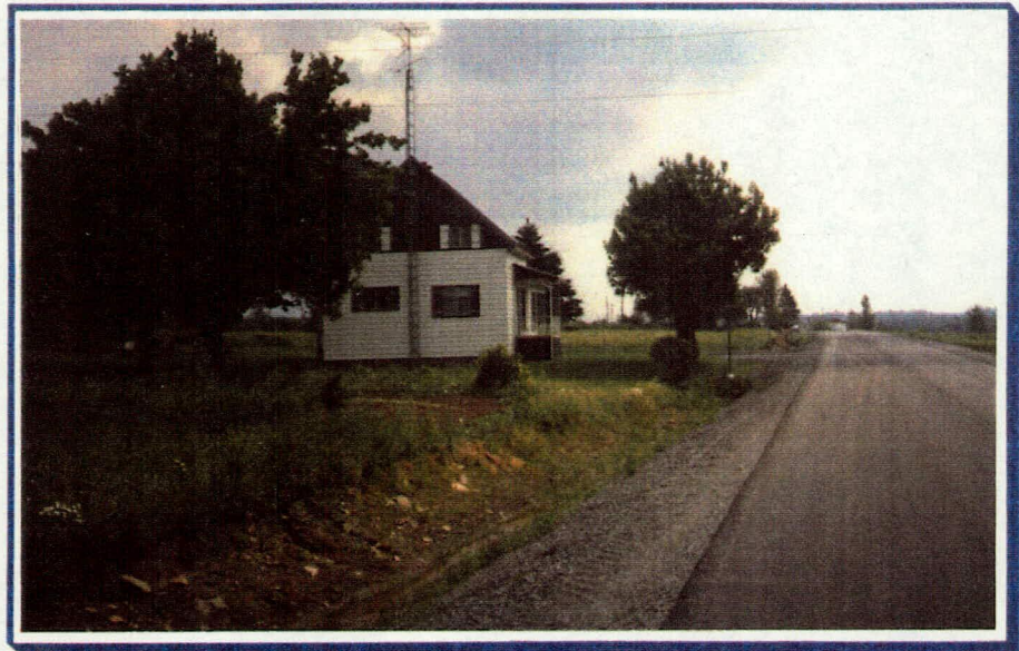
PHOTO 15: Le retrait d'emprise montré à la figure 16 est à peine perceptible lorsqu'on est sur la route.
