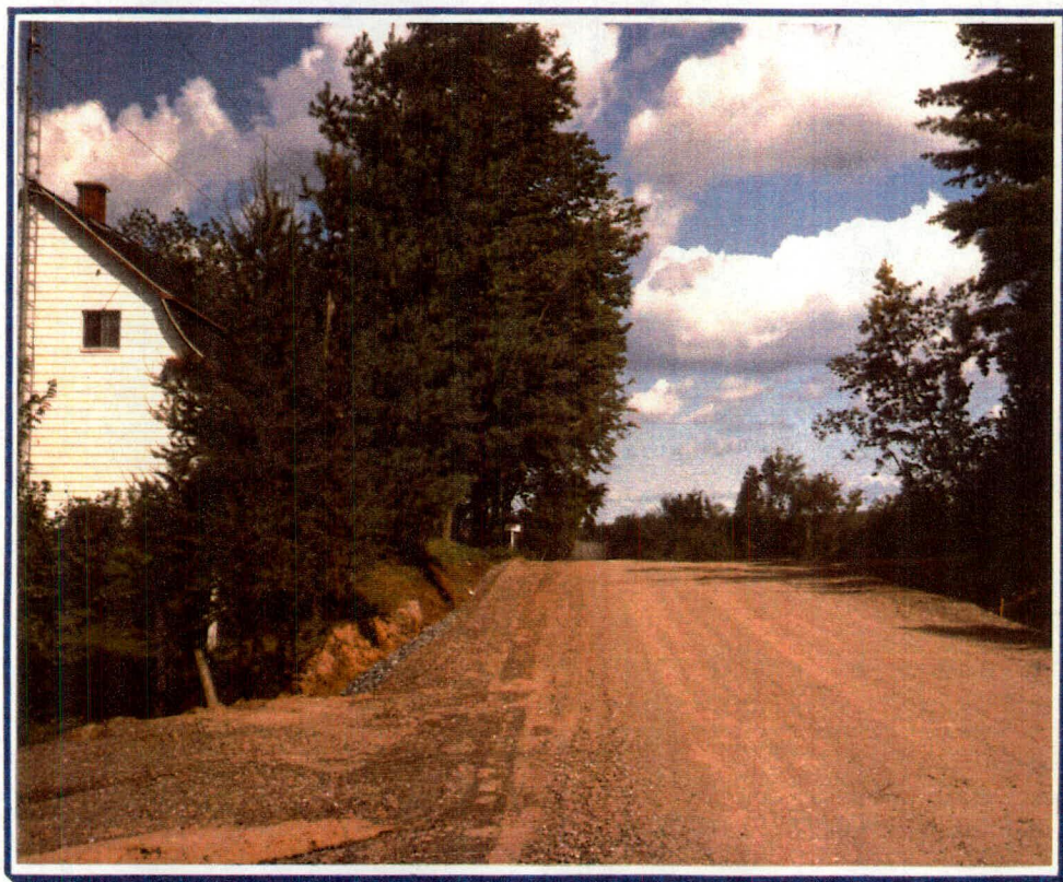
PHOTO 3 Utilisation d'un point haut naturel pour éviter l'expropriation d'une maison et conserver le cadre environnemental de la propriété
