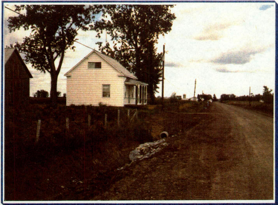
PHOTO 13 Limite de l'efficacité d'un drainage fermé comme mesure d'atténuation dans un cas de rapprochement de maison
