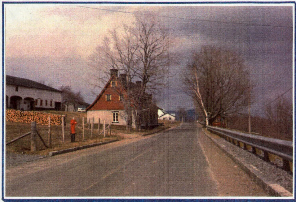
PHOTO 22 Section réduite à 5,5 m
