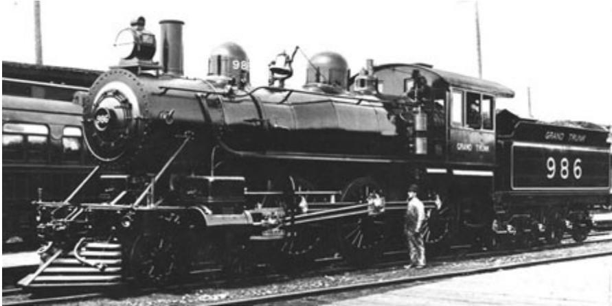
**Image 1 : Locomotive à vapeur no. 986 " Ten Wheeler " des Chemins de fer du Grand Trunk, 1900, CSTM/CN003833**
