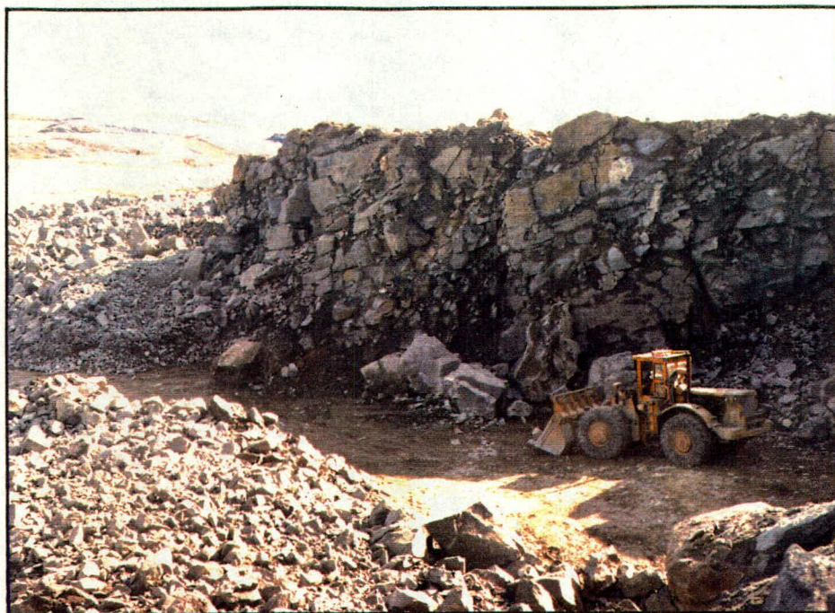
FIGURE 17: VUE SUR LA CARRIÈRE SITUÉE PRÈS DE LA PISTE EN CONSTRUCTION
