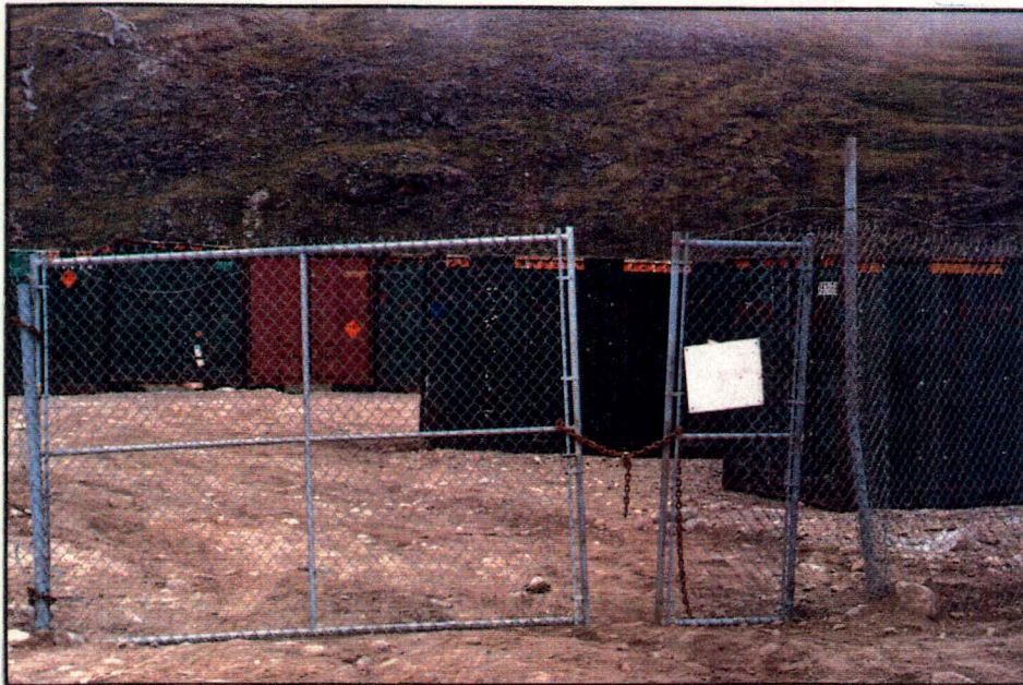
FIGURE 19: ENTRÉE DU SITE D'ENTREPOSAGE DE DYNAMITE
