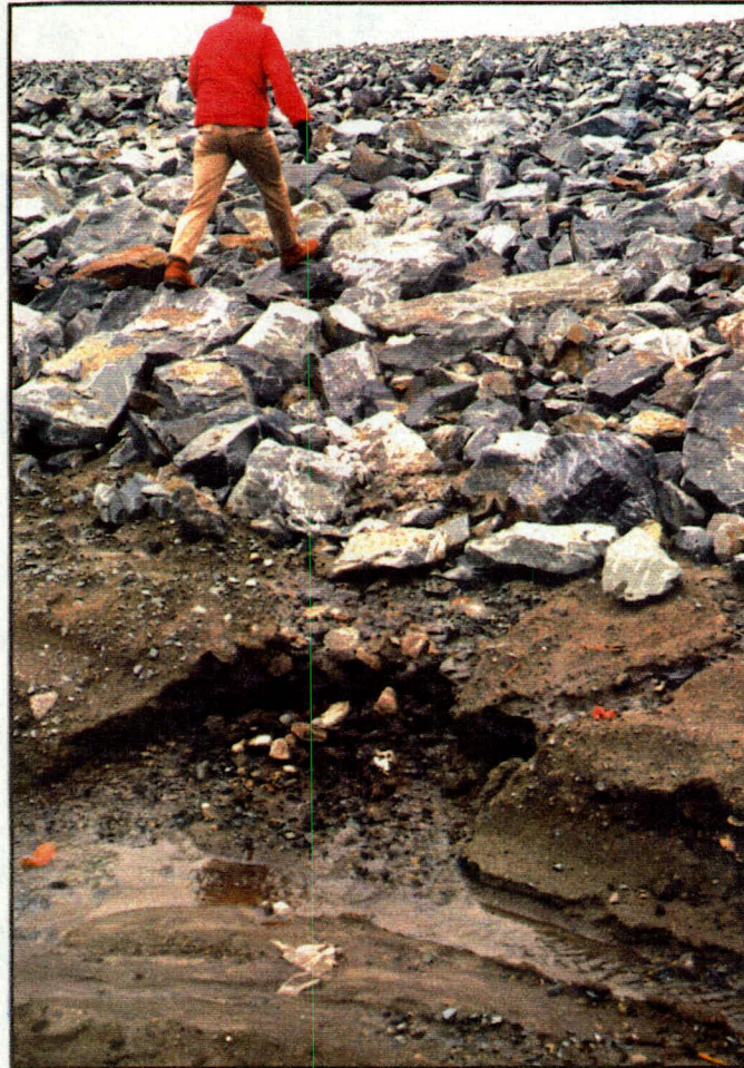
FIGURE 5: ÉCOULEMENT SOUS LE TABLIER DE LA PISTE VERS LE CHAINAGE 0+660.
