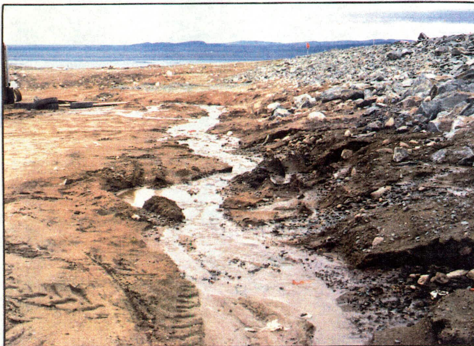
FIGURE 4 ÉCOULEMENT SOUS LA PISTE ET LATÉRAL; COTÉ EST DE LA PISTE VERS LE CHAINAGE 0+660
