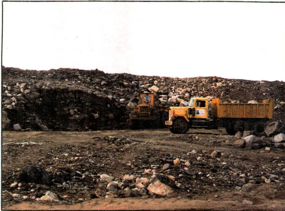
FIGURE 20: EXPLOITATION PAR LA MUNICIPALITÉ D'IVUJIVIK DE LA CARRIÈRE RÉGALÉE PAR LE M.T.Q. ET SITUÉE DU CÔTÉ "EST" DE LA PISTE
