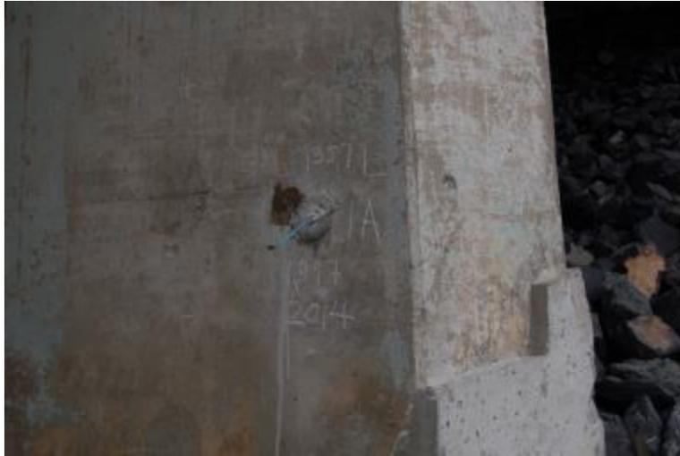
Figure 73 Réparation par rapiçage observée sur le pilier 1A du pont 13577
