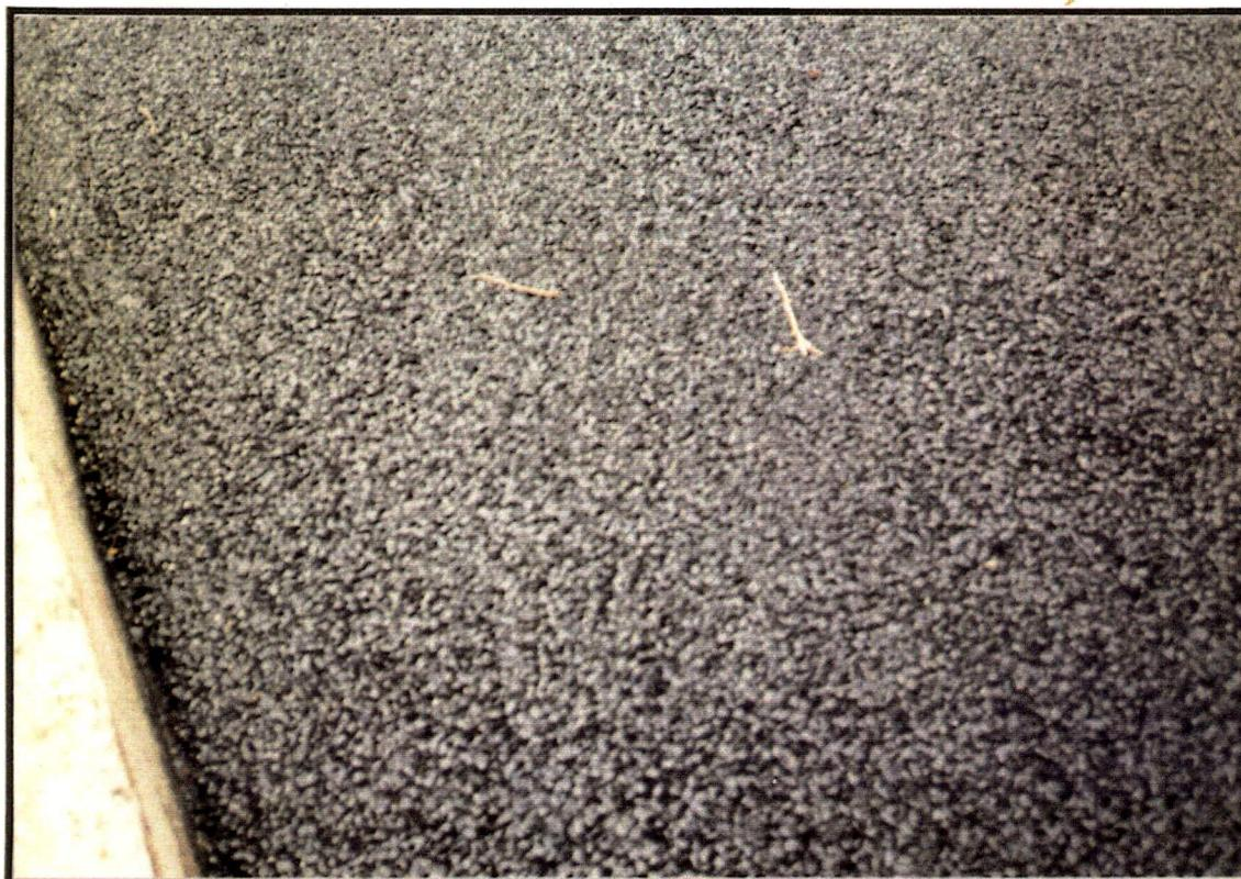
Un enrobé drainant est un revêtement constitué d'environ 20% de vide dans le but d'avoir un drainage rapide des eaux de ruissellement. L'évacuation des eaux de pluie se fait à l'intérieur de la couche et de là vers les côtés de la chaussée avec une pente d'environ 2% formée par la couche de forme qui est imperméable. Normalement on ferme les côtés, on doit donc préalablement poser des drains.
