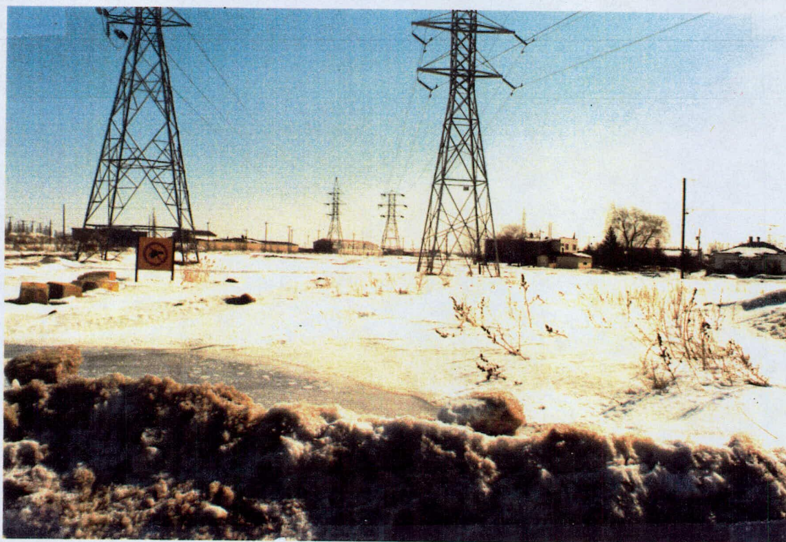
PHOTO 10 La présence des pylônes d'Hydro-Québec maintient un milieu dégagé sans grande végétation.
