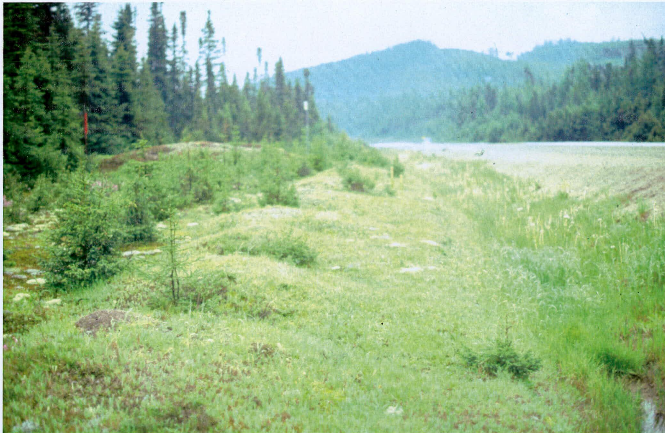
Figure 17: Secteur Y, vue du bourrelet formé par les déblais du fossé, en direction sud-ouest, entre le KM 3+000 et 3+260
