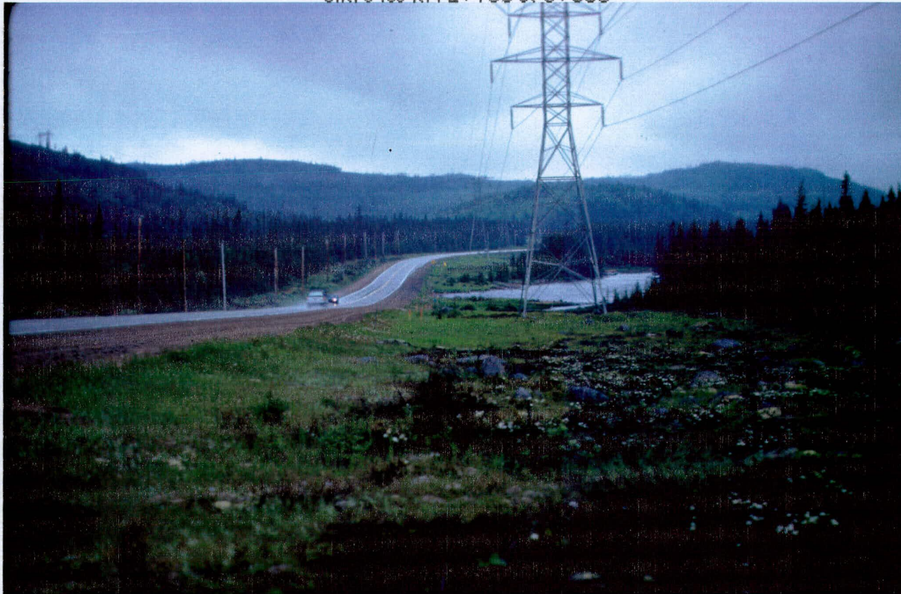
Figure 20: Secteurs IV et V, vue générale de la zone sondée, en direction nord-ouest, entre les KM 2+700 et 3+500
