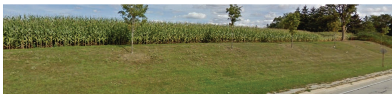
Figure 2.30 : Berme en bordure de route
