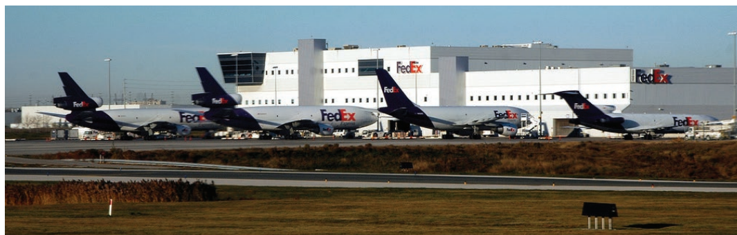
Figure 1.7 : Installation de FedEx à l'aéroport international Lester B. Pearson de Toronto
