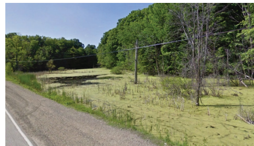
Figure 2.31 : Élément naturel directement adjacent à la rue sans fossé ou rigole de drainage biologique
