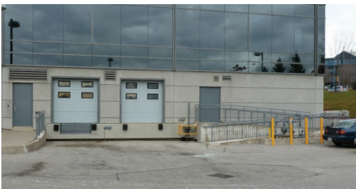
Figure 3.10 : Rampe de quai de chargement
