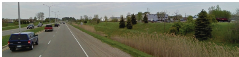
Figure 2.28 : Rigole de drainage biologique
