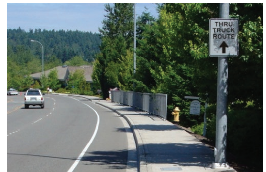
Figure 2.20 : Exemple de voie cyclable
