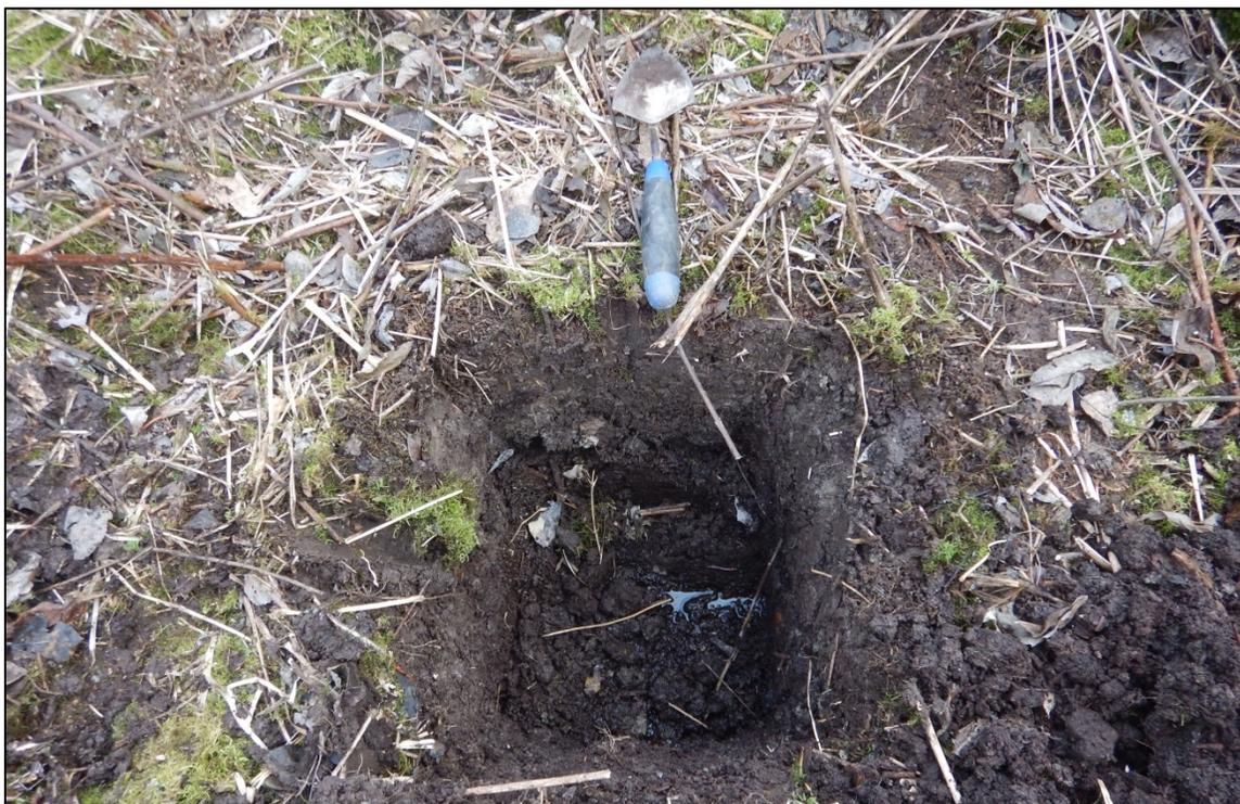
**Photo 44 : Projet 154-00-0514, sondage exploratoire réalisé à l'intérieur de l'emprise de la servitude #14**
