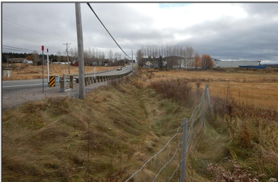
**Photo 29 : Projet 154-00-0514, fossé d'écoulement des eaux localisé à l'intérieur de l'emprise de la zone #2**
