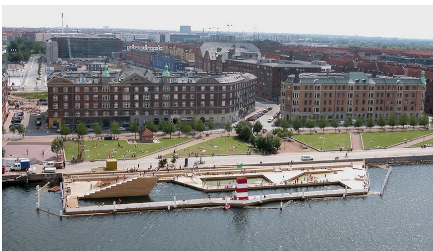
Figure 33 : Vue aérienne du site d'Islands Brygge et du Harbour Park
