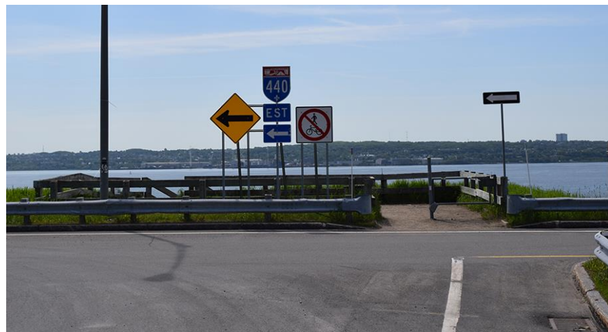
Figure 13 : La petite jetée de Beauport, exemple d'un site dont l'accès est largement contraint par un axe de transit important. Le projet de requalification du littoral est vise à recomposer cette bordure fluviale
