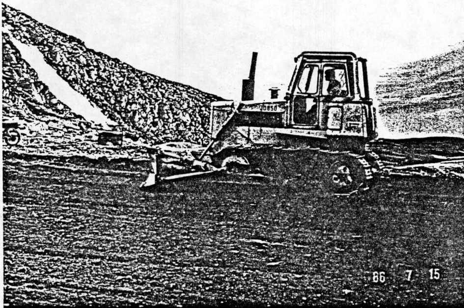
Figure 16 Site E-1986. Préparation du terrain au bélief mécanique (86-7-15).
