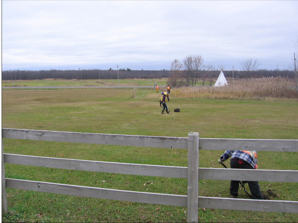
Photo 33 Secteur 7, zone décapée, gazonnée, chaînage 150+100, direction ouest (MTQ1528-NUM1-15-105)
