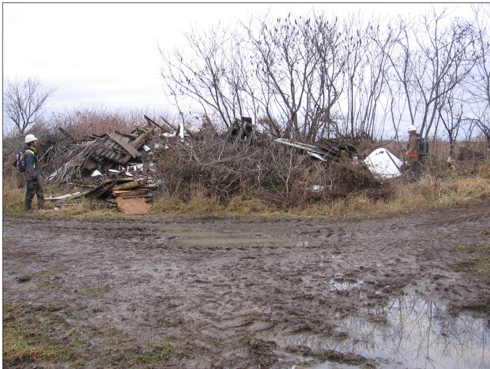
Photo 14 Secteur 2, dépotoir, chaînage 136+900, direction nord-est (MTQ1528-NUM1-15-150)
