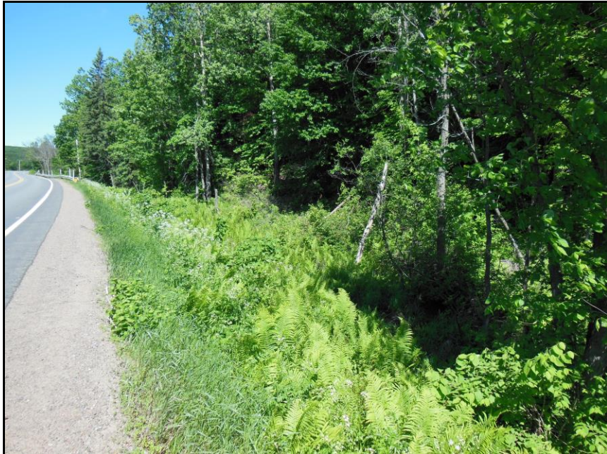
Photo 4 Emprise du côté est de la route 349 entre les chaînages 7+600 et 7+700, vers l'est (DUCD-13-1156-019)
