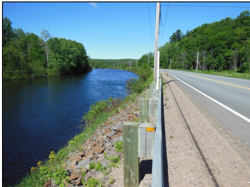
Photo 8 Emprise du côté ouest de la route 349 à proximité du chaînage 7+500, vers l'ouest (DUCD-13-1156-023)
