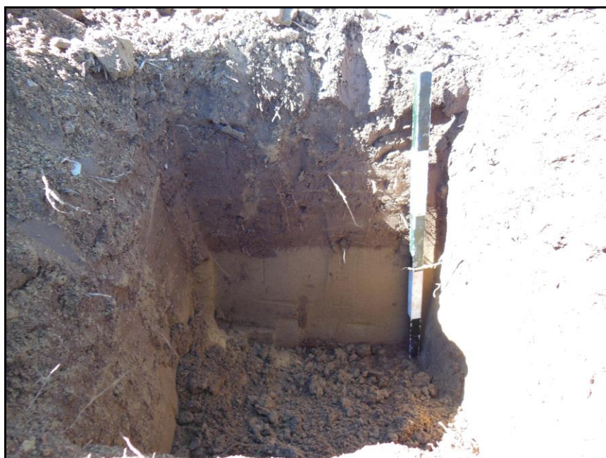
Photo 6 Paroi nord d'un sondage effectué près du chaînage 7+930, vers le nord (DUCD-13-1156-015)
