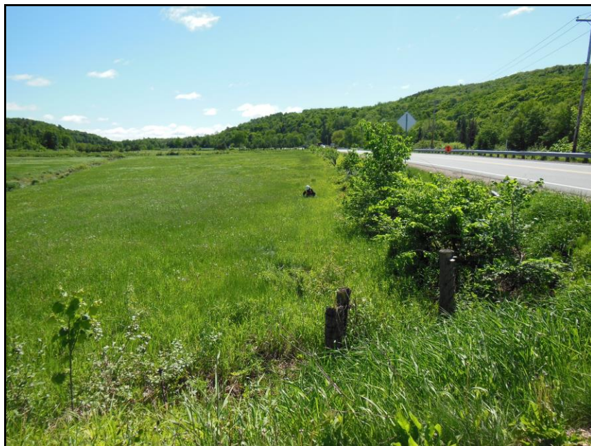
Photo 1 Emprise du côté est de la route 349 entre les chaînages 7+230 et 7+400, vers l'est (DUCD-13-1156-022)
