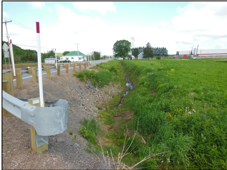
Photo 7 Emprise du côté est de la route 349 entre les chaînages 8+500 et 9+410, vers le sud-sud-est (DUCD-13-1156-006)
