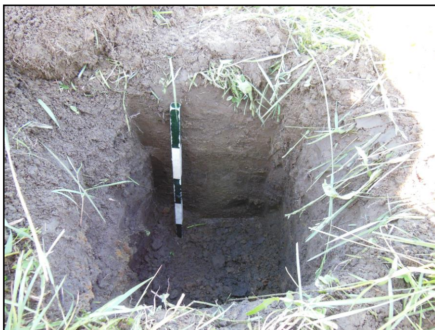
Photo 2 Paroi nord d'un sondage effectué près du chaînage 7+320, vers le nord (DUCD-13-1156-025)
