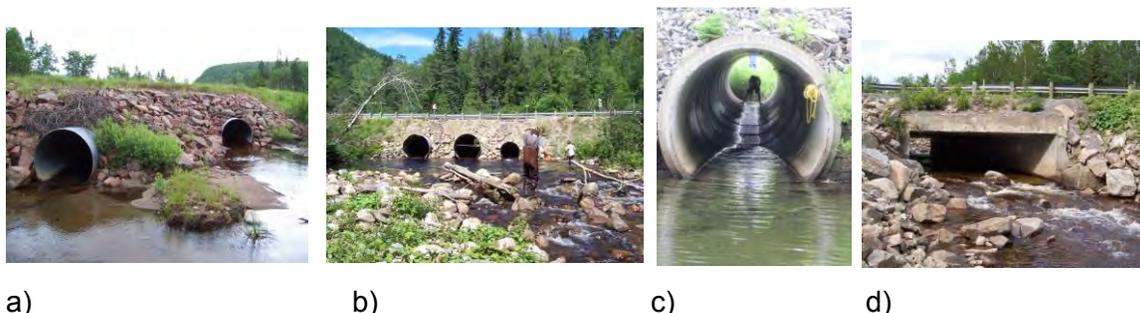
**Figure 1 : Différents types de ponceaux : a) et b) circulaire en tôle ondulée galvanisée; c) circulaire en béton armé; d) rectangulaire en béton armé**
