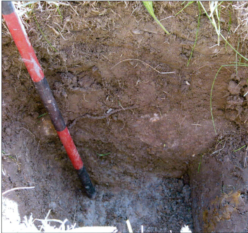
Photo 21 : Projet n° 154-06-1564, ponceau n° 4220-0, route 204, municipalité de Saint-Damase-de-L'Islet, paroi sud d'un sondage. Direction sud (photo 154-06-1564-29).
