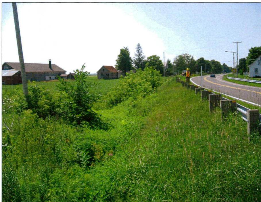
Photo 48 : Projet n° 154-06-1561, ponceau n° 0677-0, route 132, municipalité de Lotbinière, vue générale de l'emprise du côté ouest de la route. Direction sud. (photo 154-06-1561-21)
