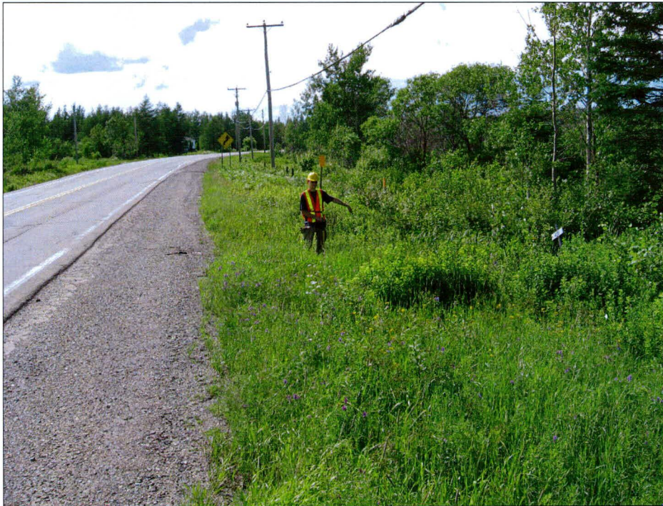
Photo 8 : Projet n° 154-03-0250, ponceau n° 4207-0, route 204, municipalité de Tourville, vue de l'emprise du côté nord de la route. Direction ouest (Photo 154-03-0250-28).
