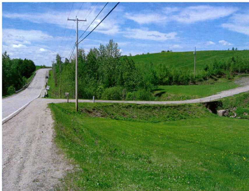
Photo 74 : Projet n° 154-94-0278, route 216, municipalité de Saint-Paul-de-Montminy, vue du côté nord de la route 216, secteur nord-est de l'emprise des travaux. Direction sud-ouest. (photo 154-94-0278-03)
