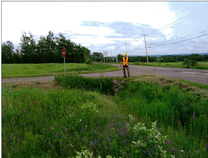
Photo 18 : Projet n° 154-06-1564, ponceau n° 2208-0, route 132, municipalité de Saint-Roch-des-Aulnaies, vue générale de l'emprise du côté nord de la route. Direction est (photo 154-06-1564-20).
