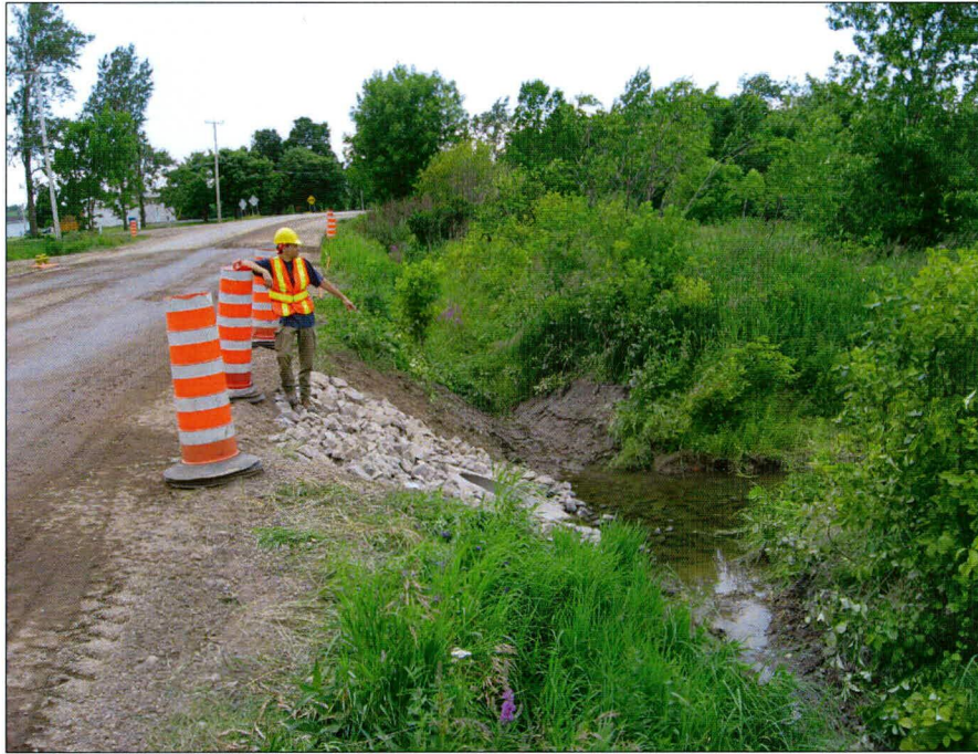
Photo 19 : Projet n° 154-06-1564, ponceau n° 2210-0, route 132, municipalité de Saint-Roch-des-Aulnaies, vue générale de l'emprise du côté nord de la route. Direction ouest (photo 154-06-1564-24).
