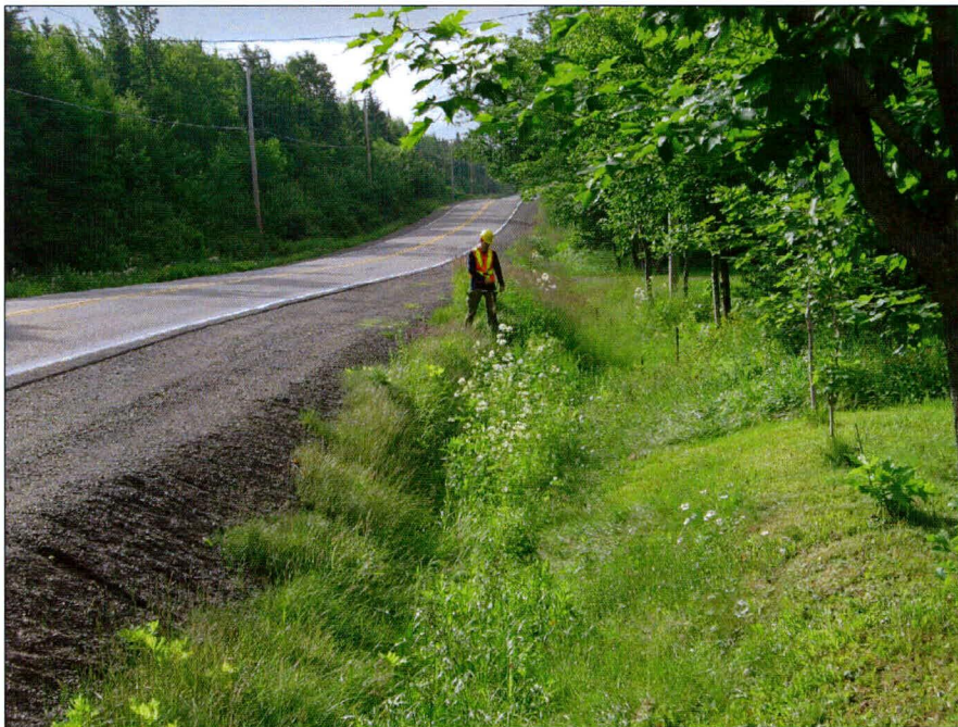
Photo 32 : Projet n° 154-06-1564, ponceau n° 3154-0, route 283, municipalité de Notre-Dame-du-Rosaire, vue générale de l'emprise du côté sud de la route. Direction est (photo 154-06-1564-57).
