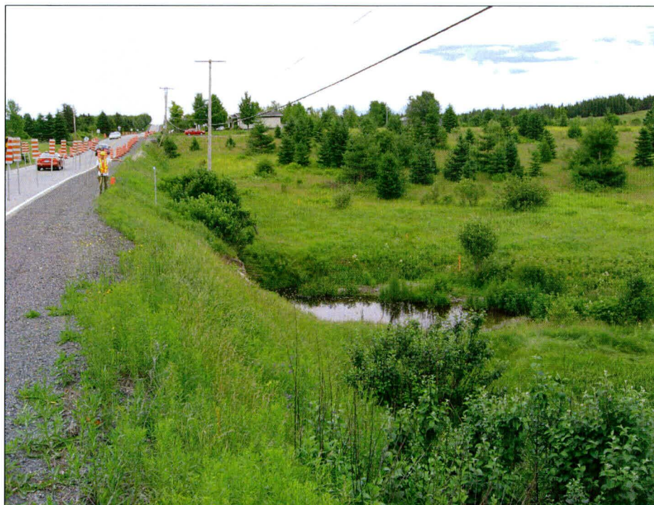
Photo 66 : Projet n° 154-03-0197, ponceau n° 16583, route 271, municipalité Saint-Benoît, vue générale de l'emprise du côté nord de la route. Direction ouest. (photo 154-03-0197-26)
