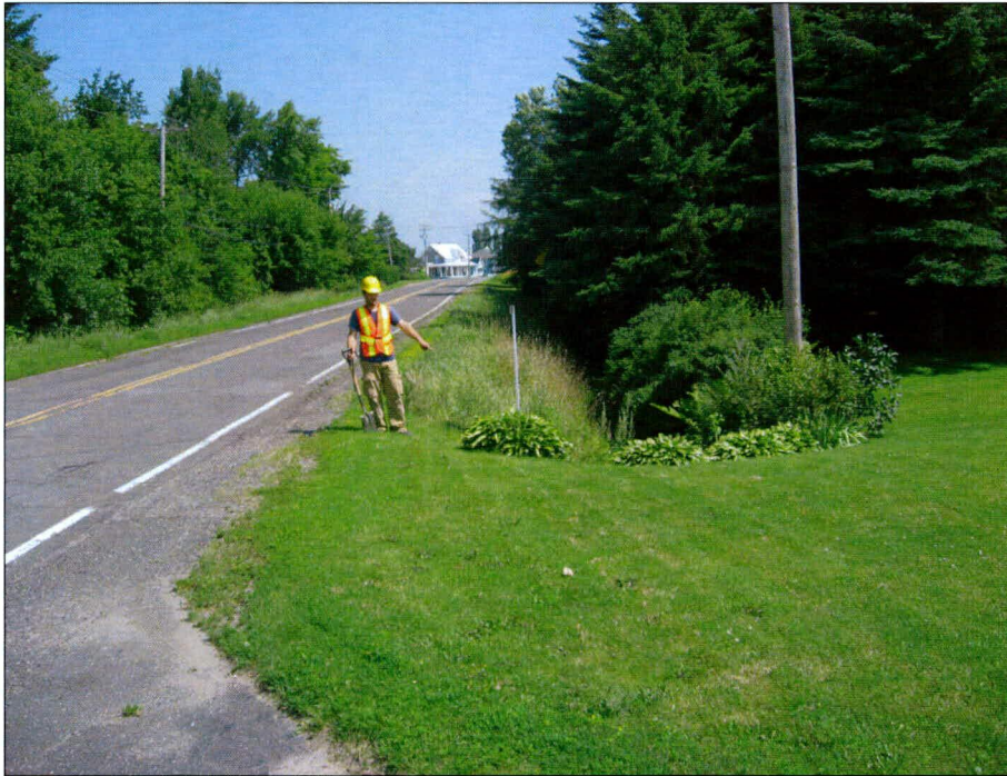
Photo 46 : Projet n° 154-06-1561, ponceau n° 0664-0, route 132, municipalité de Lotbinière, vue générale de l'emprise du côté sud de la route. Direction est. (photo 154-06-1561-12)
