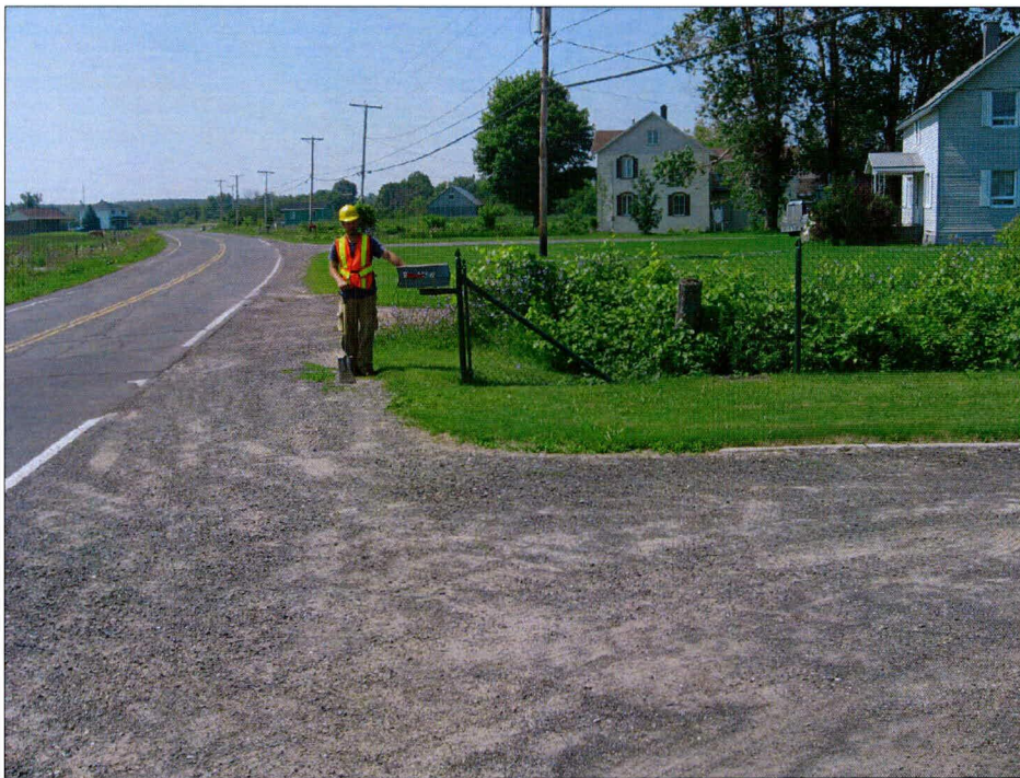
Photo 41 : Projet n° 154-97-0280, ponceau n° 0663-0, route 132, municipalité de Lotbinière, vue générale de l'emprise du côté nord de la route. Direction ouest (photo 154-97-0280-12).
