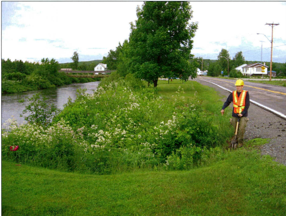
Photo 28 : Projet n° 154-06-1564, ponceau n° 8142-0, route 204, municipalité de Sainte-Lucie-de-Beauregard, vue générale de l'emprise du côté nord-ouest de la route. Direction nord (photo 154-06-1564-51).
