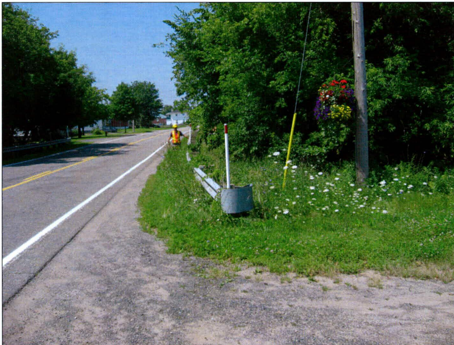
Photo 47 : Projet n° 154-06-1561, ponceau n° 0674-0, route 132, municipalité de Lotbinière, vue générale de l'emprise du côté ouest de la route. Direction sud. (photo 154-06-1561-16)
