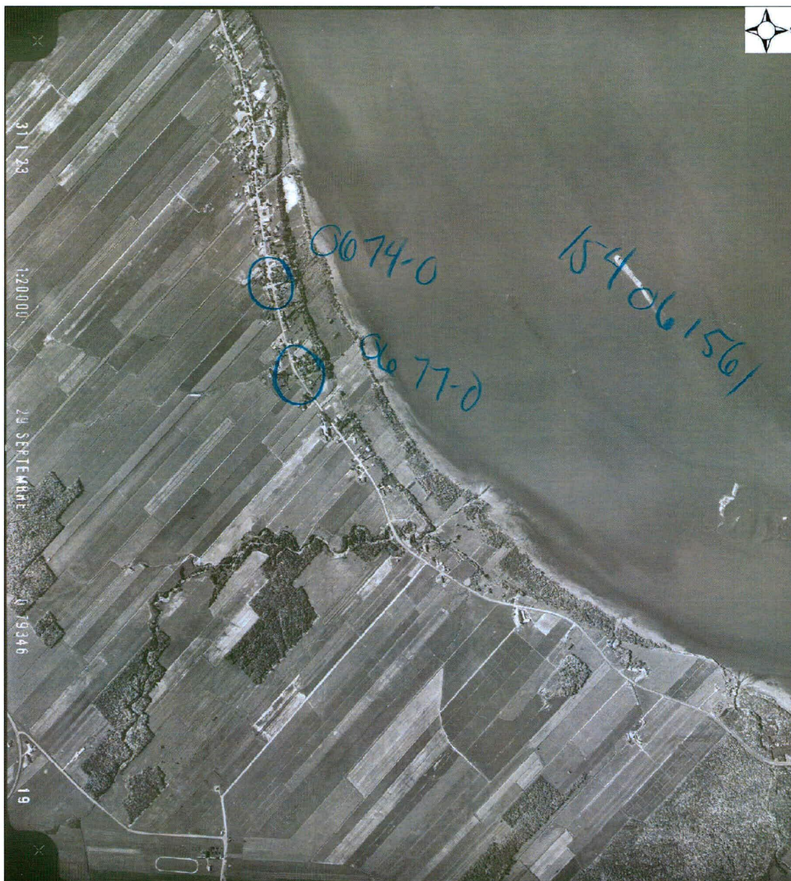
Figure 35 : Localisation sur photo aérienne des ponceaux n° 0674-0 et n° 0677-0, projet n° 154-06-1561, route 132, municipalité de Lotbinière (Source : Photocartotheque du Québec, Q79346-19, échelle 1:15 000)
