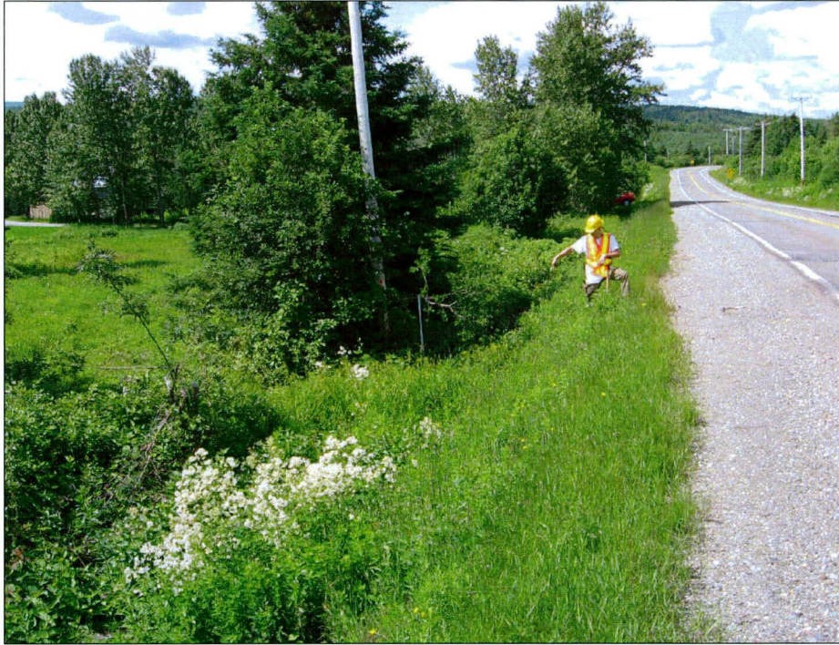
Photo 35 : Projet n° 154-06-1564, ponceau n° 6032-0, route 216, municipalité de Saint-Paul-de-Montminy, vue générale de l'emprise du côté sud de la route. Direction ouest (photo 154-06-1564-73).
