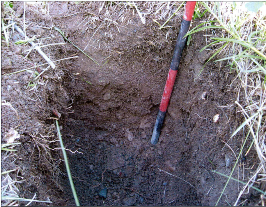
Photo 9 : Projet n° 154-03-0250, ponceau n° 4207-0, route 204, municipalité de Tourville, paroi est du sondage du côté nord de la route. Direction est (photo 154-03-0250-33).
