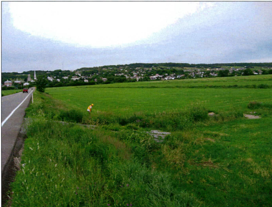
Photo 69 : Projet n° 154-03-0197, ponceau n° 16690, route 276, municipalité Saint-Joseph-de-Beauce, vue générale de l'emprise du côté sud-est de la route. Direction est. (photo 154-03-0197-31)
