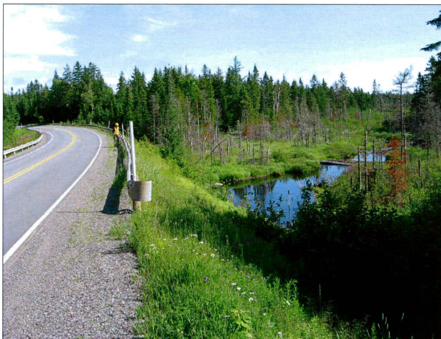
Photo 33 : Projet n° 154-06-1564, ponceau n° 3148-0, route 283, municipalité de Notre-Dame-du-Rosaire, vue générale de l'emprise du côté ouest de la route. Direction nord (photo 154-06-1564-64).
