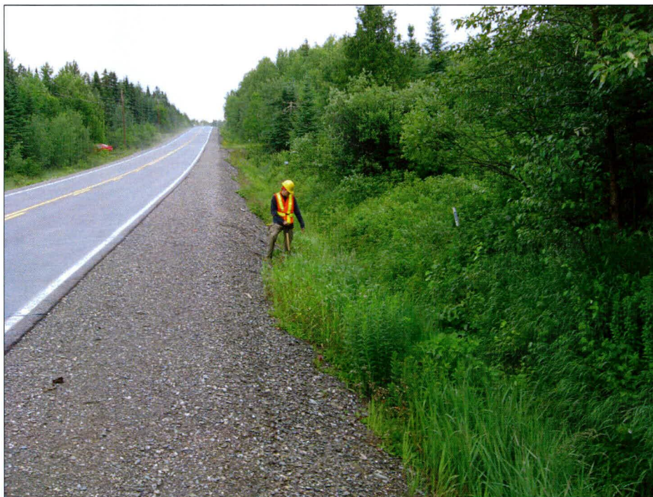
Photo 26 : Projet n° 154-06-1564, ponceau n° 4056-0, route 204, municipalité de Lac-Frontière, vue générale de l'emprise du côté est de la route. Direction nord (photo 154-06-1564-43).
