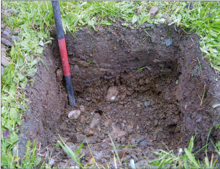
Photo 29 : Projet n° 154-06-1564, ponceau n° 8142-0, route 204, municipalité de Sainte-Lucie-de-Beaugard, paroi nord-ouest d'un sondage du côté nord-ouest de la route. Direction nord-ouest (photo 154-06-1564-53).
