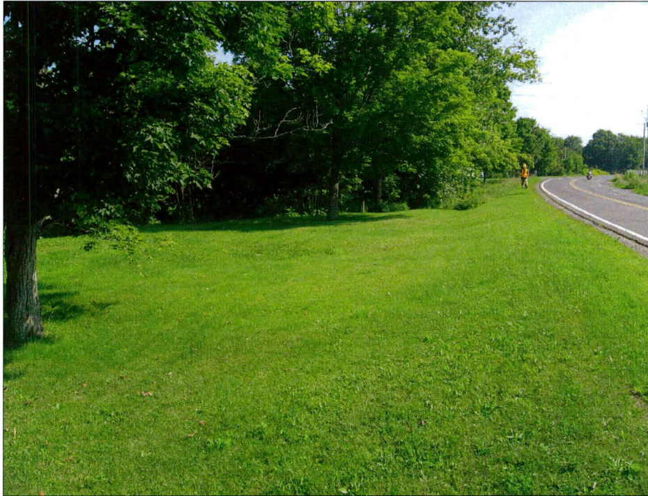
Photo 42 : Projet n° 154-06-1561, ponceau n° 0648-0, route 132, municipalité de Lotbinière, vue générale de l'emprise du côté est de la route. Direction nord-est (photo 154-06-1561-4)
