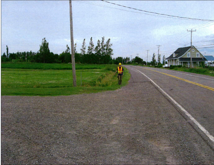
Photo 17 : Projet n° 154-06-1564, ponceau n° 2202-0, route 132, municipalité de Saint-Roch-des-Aulnaies, vue générale de l'emprise du côté sud de la route. Direction ouest (photo 154-06-1564-13).
