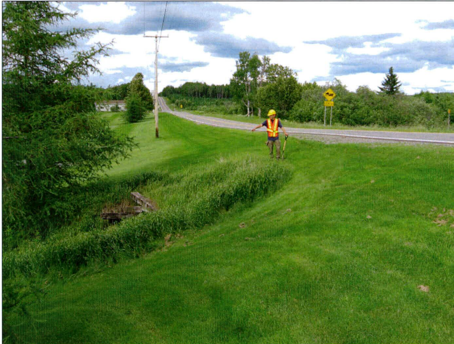
Photo 10 : Projet n° 154-03-0250, ponceau n° 9009-0, rang des Pelletier, municipalité de Saint-Pamphile, vue générale de l'emprise du côté nord-ouest de la route. Direction ouest (photo 154-03-0250-35).
