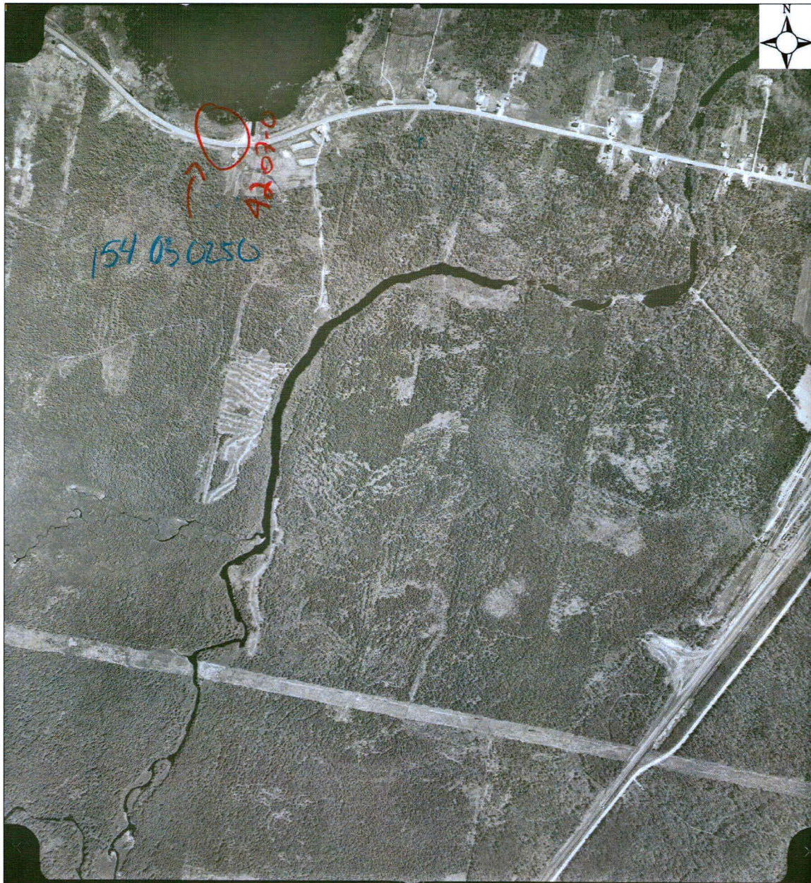
Figure 12 : Localisation sur photo aérienne du ponceau n° 4207-0, projet n° 154-03-0250, route 204, municipalité de Tourville (Source : Photocartotheque du Québec, Q76338-71, échelle 1:15 000)
