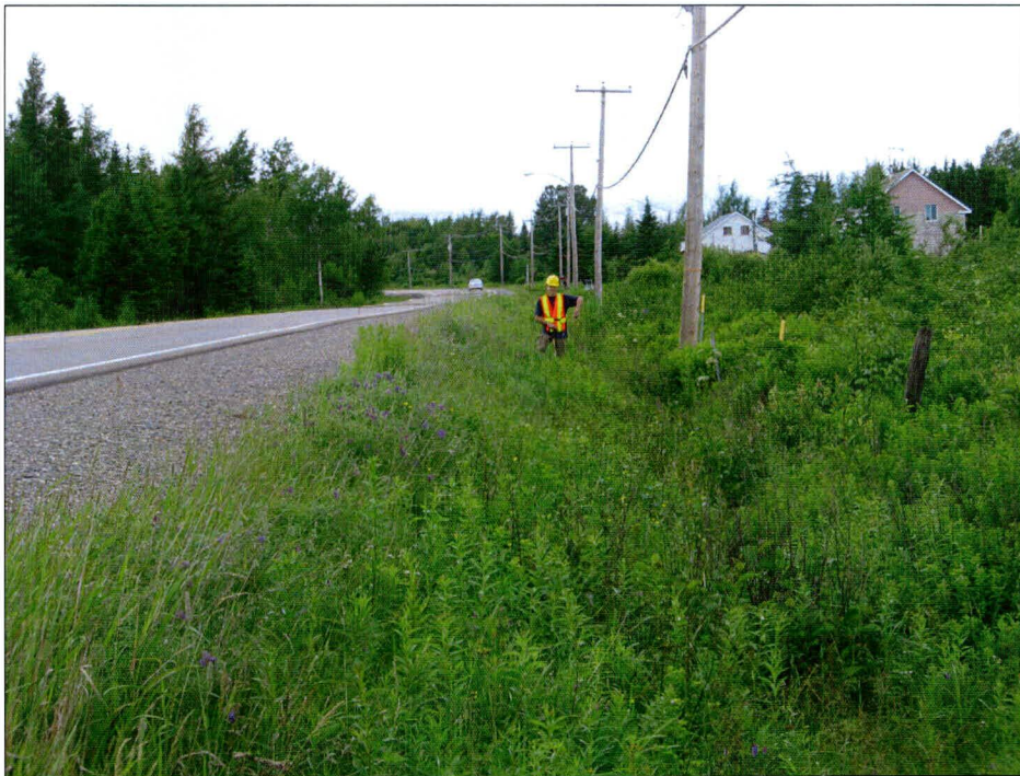
Photo 24 : Projet n° 154-06-1564, ponceau n° 4203-0, route 204, municipalité de Tourville, vue générale de l'emprise du côté nord de la route. Direction ouest (photo 154-06-1564-35).
