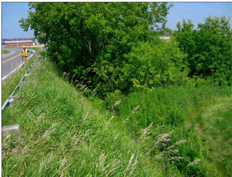
Photo 49 : Projet n° 154-06-1561, ponceau n° 0685-0, route 132, municipalité de Lotbinière, vue générale de l'emprise du côté est de la route. Direction nord. (photo 154-06-1561-28)
