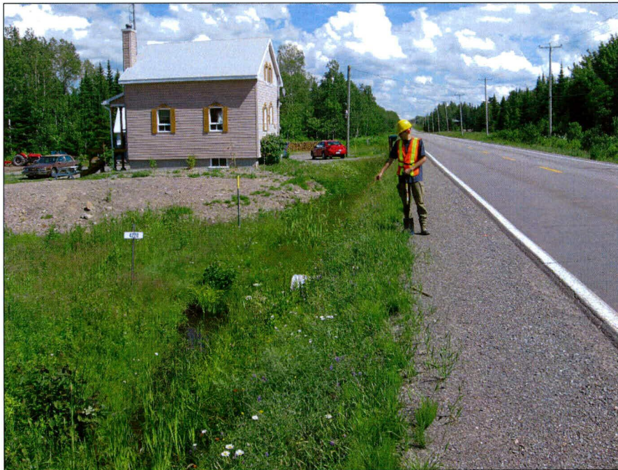
Photo 20 : Projet n° 154-06-1564, ponceau n° 4220-0, route 204, municipalité de Saint-Damase-de-L'Islet, vue générale de l'emprise du côté nord de la route. Direction est (photo 154-06-1564-26).
