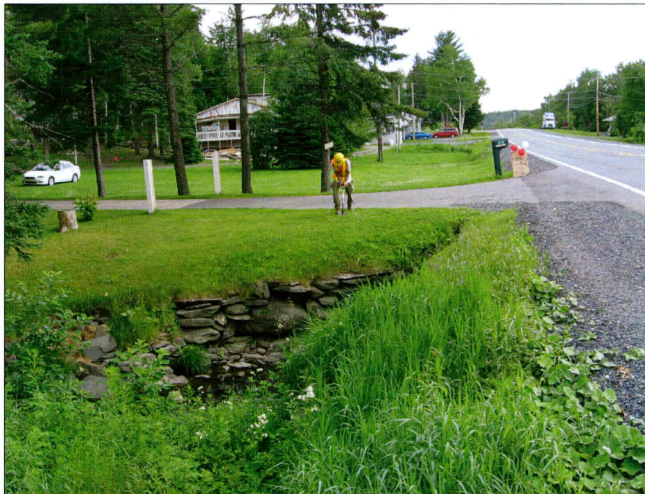
Photo 62 : Projet n° 154-03-0197, ponceau n° 16429, route 204, ville de Saint-Georges, vue générale de l'emprise du côté est de la route. Direction sud. (photo 154-03-0197-8)
