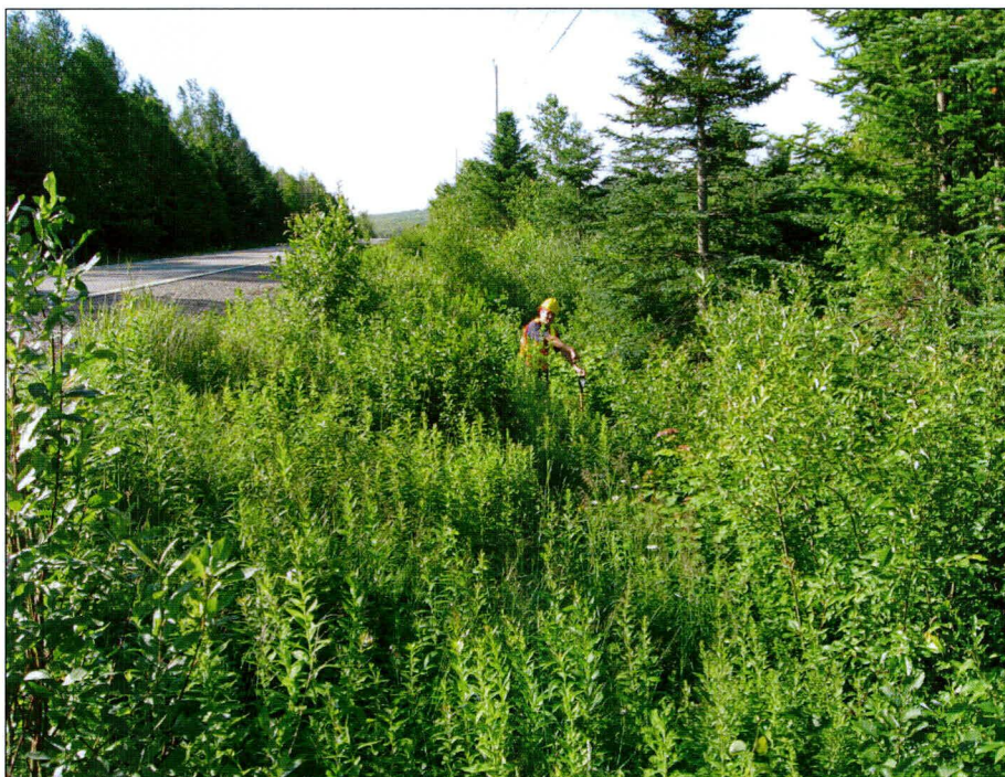
Photo 13 : Projet n° 154-06-1564, ponceau n° 5081-0, route 285, municipalité de Saint-Cyrille-de-Lessard, vue générale de l'emprise du côté ouest de la route. Direction sud (photo 154-06-1564-4).
