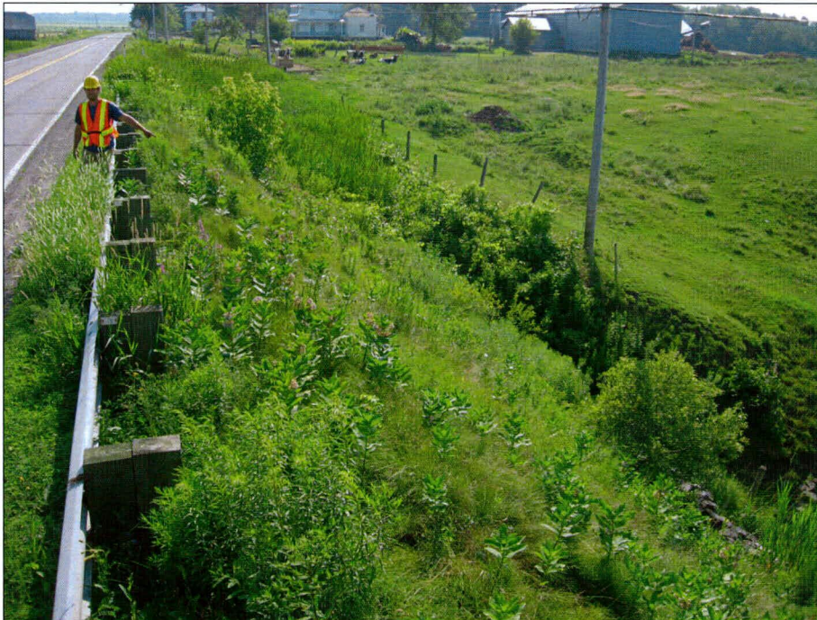
Photo 55 : Projet n° 154-06-1561, ponceau n° 0777-0, route 132, municipalité de Lotbinière, vue générale de l'emprise du côté ouest de la route. Direction sud. (photo 154-06-1561-47)
