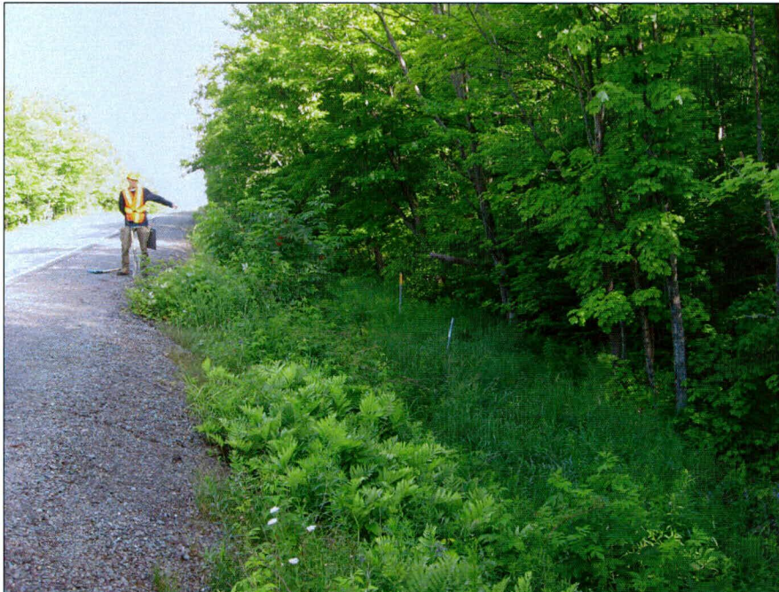
Photo 30 : Projet n° 154-06-1564, ponceau n° 3152-0, route 283, municipalité de Notre-Dame-du-Rosaire, vue générale de l'emprise du côté nord-est de la route. Direction nord-ouest (photo 154-06-1564-59).
