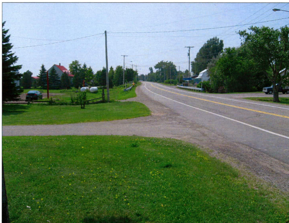
Photo 56 : Projet n° 154-06-1532, ponceau n° 12496, route 132, municipalité de L'Islet, vue générale de l'emprise du côté ouest de la route. Direction sud-ouest. (photo 154-06-1532-6)
