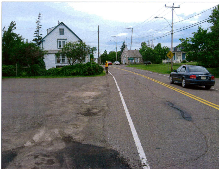
Photo 3 : Projet n° 154-03-0250, ponceau n° 2205-0, route 132, municipalité de Saint-Roch-des-Aulnaies, vue générale de l'emprise du côté sud de la route. Direction ouest (photo 154-03-0250-12).
