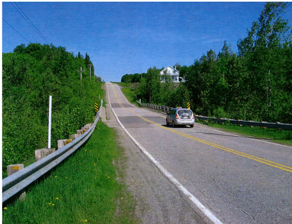
Photo 73 : Projet n o 154-98-0191, rang Saint-Jacques, municipalité de Saint-Séverin, vue générale depuis la limite sud de l'emprise des travaux. Direction nord. (photo 154-98-0191-01)
