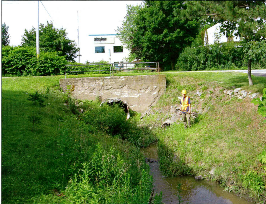
Photo 15 : Projet n° 154-06-1564, ponceau n° 5109-0, route 285, municipalité de L'Islet, vue de l'emprise et du ponceau du côté nord-est de la route. Direction sud-ouest (photo 154-06-1564-9).
