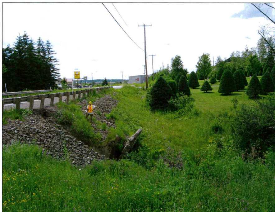
Photo 60 : Projet n° 154-03-0197, ponceau n° 12501, route 173, municipalité de Saint-Côme-de-Linière, vue générale de l'emprise du côté nord de la route. Direction ouest. (photo 154-03-0197-2)
