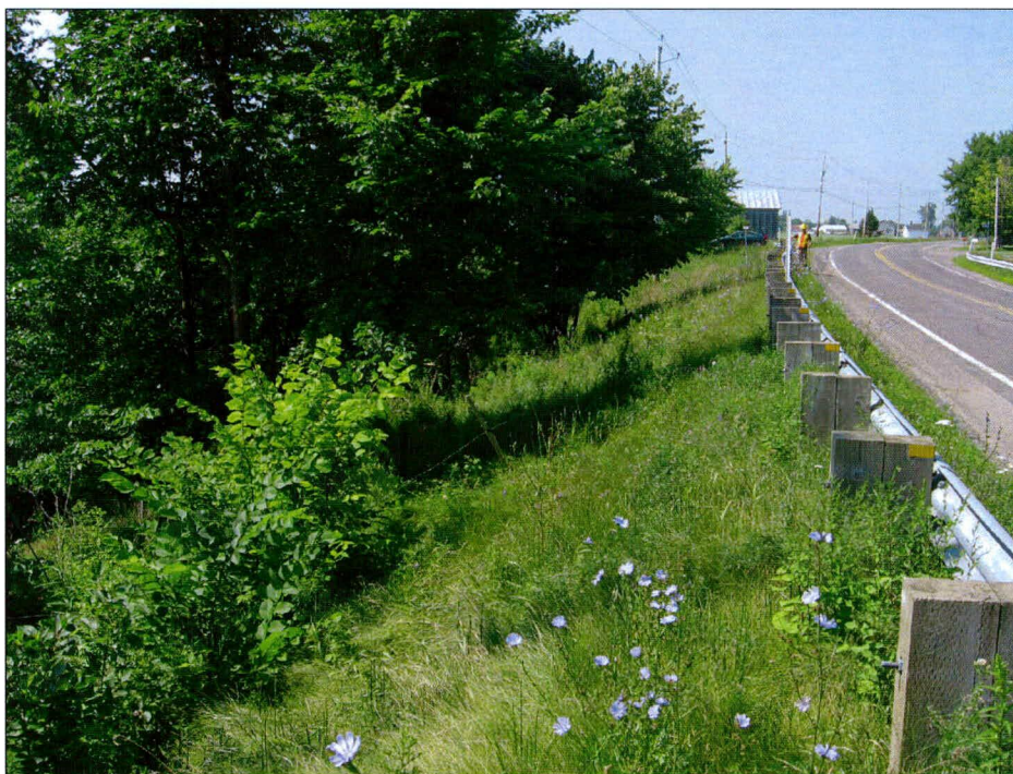
Photo 39 : Projet n° 154-97-0280, ponceau n° 0652-0, route 132, municipalité de Lotbinière, vue générale de l'emprise du côté sud-est de la route. Direction ouest (photo 154-97-0280-8).
