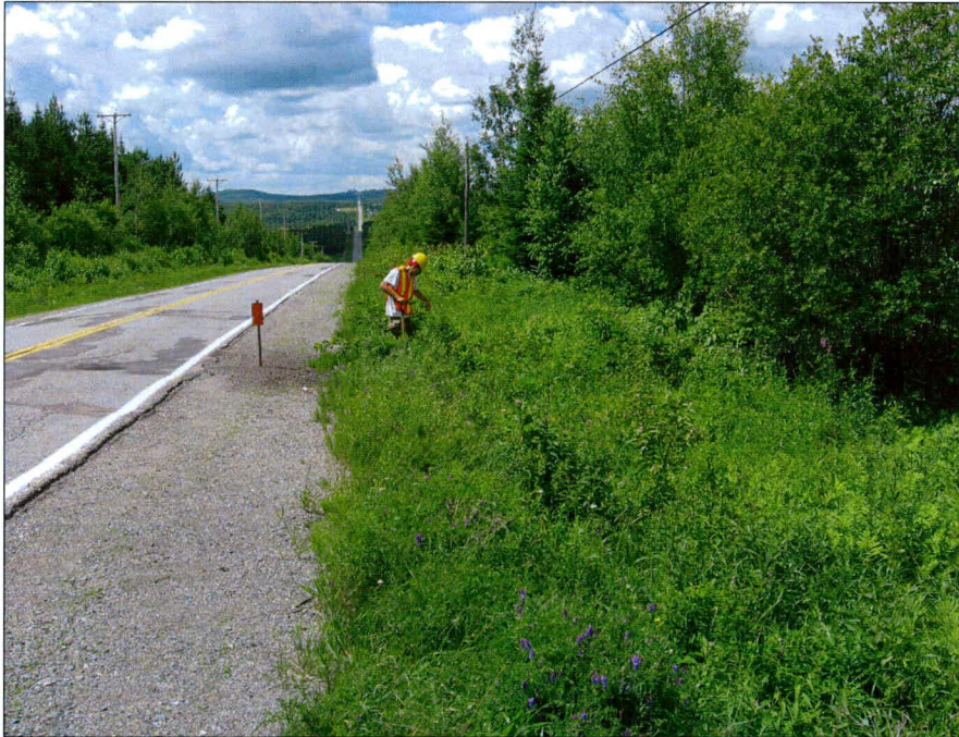
Photo 11 : Projet n° 154-03-0250, ponceau n° 8121-0, rue Principale Est, municipalité de Saint-Fabien-de-Panet, vue générale de l'emprise du côté est de la route. Direction nord (photo 154-03-0250-41).
