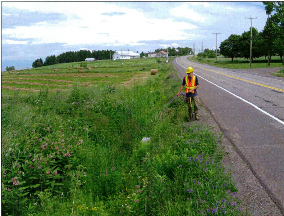
Photo 2 : Projet n° 154-03-0250, ponceau n° 2187-0, route 132, municipalité de Saint-Roch-des-Aulnaies, vue générale de l'emprise du côté nord-ouest de la route. Direction nord-est (photo 154-03-0250 -10).
