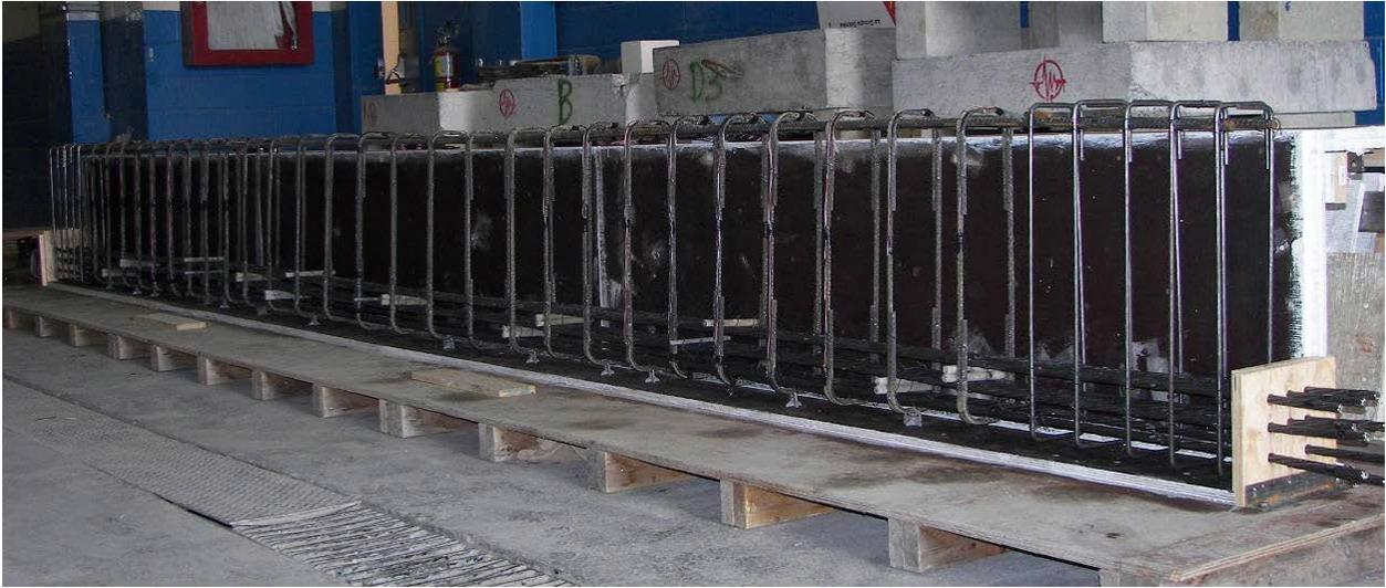
Figure 12 – Détails d'armatures de la poutre SC-9,5-3
