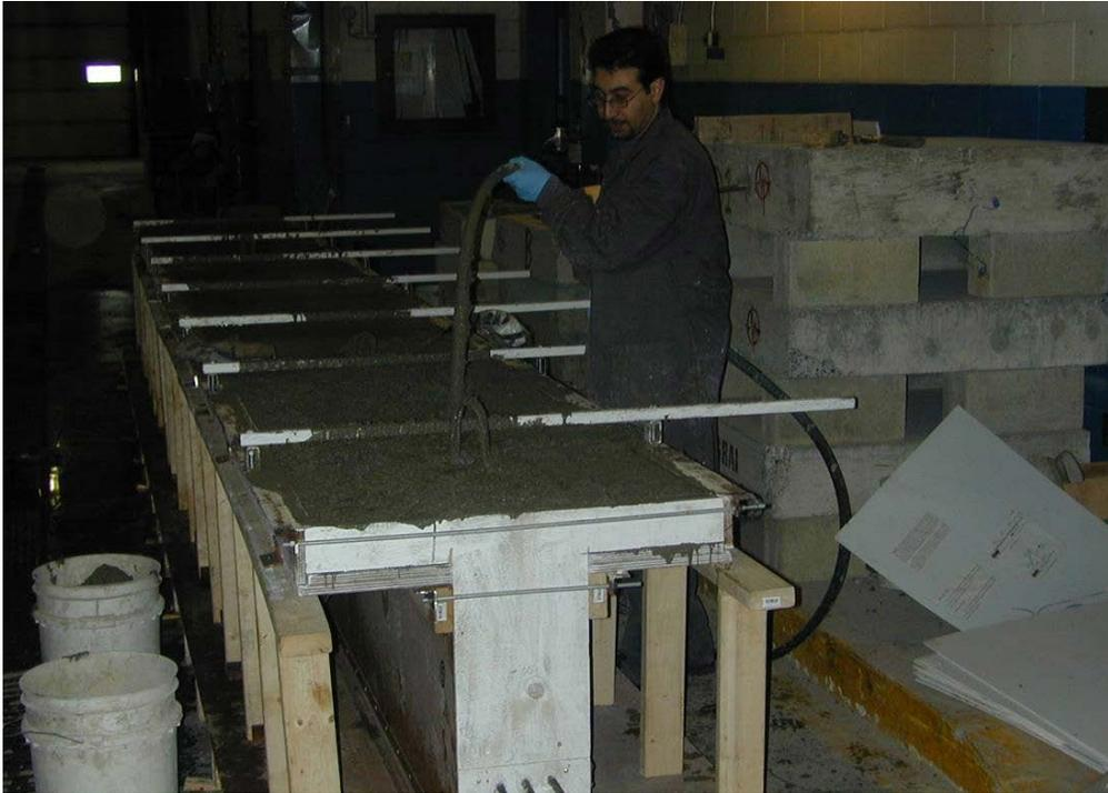
Figure 10 – Coulage de la poutre SC-9,5-2
