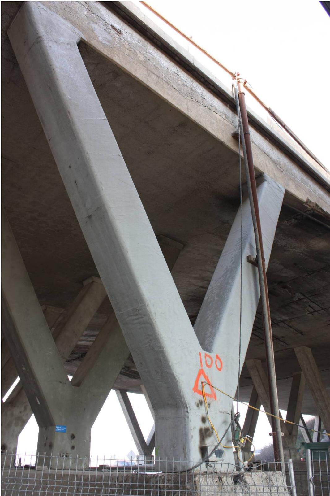
Figure C10 : Vue d'ensemble, colonne Y24 (traitée avec *Sika wrap*).
