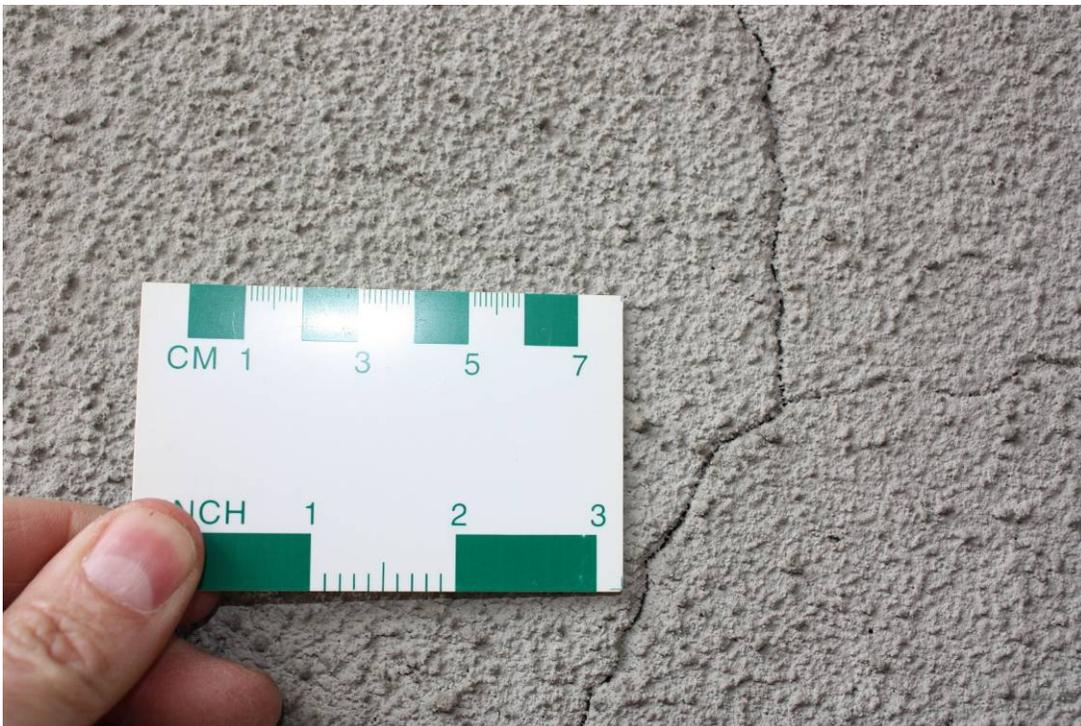
Figure C4 (suite): F à H : Vues rapprochées de la fissuration, colonne Y28 (traitée avec *Masterseal SL* et enduit *Texcote*).
