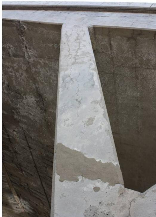
Figure C1 (suite) : Vues rapprochées, colonne Y25. B. Fût, face sud. C. Branche est – dessus. D. gros plan de la fissuration. E. Branche est, face nord.
