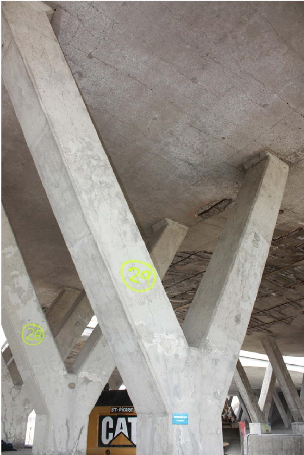
Figure C3 : Vue d'ensemble, colonne Y29 (traitée avec *Planiseal*).
