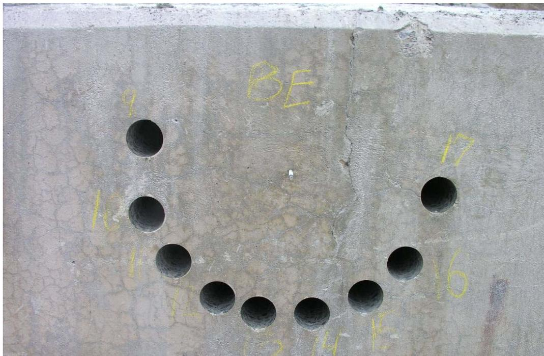
Figure 4.43 (suite). Condition et zones d'échantillonnage de base massives de l'échangeur Robert-Bourassa – Charest. C. Gros plan de la zone de carottage no. 1 (exposée) de la photo précédente; présence de macrofissures. D. Gros plan de la zone de carottage no. 2 (non exposée) de la photo précédente; présence d'une macrofissure verticale et d'un fin motif de fissuration polygonale.
