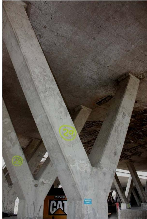
Figure 4.38 : Aspect général des colonnes Y28 (*Masterseal SL*) et Y29 (*Planiseal*).
