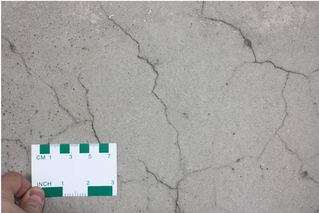
Figure C2 (suite): F à H : Vues rapprochées de la fissuration, colonne Y28 (traitée avec *Masterseal SL*).
