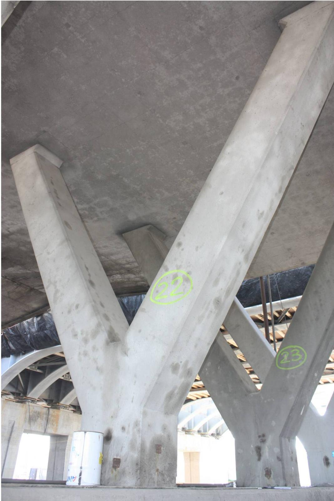
Figure C8 : Vue d'ensemble, colonne Y22 (traitée avec *Masterseal SL* et enduit *Miracote*).
