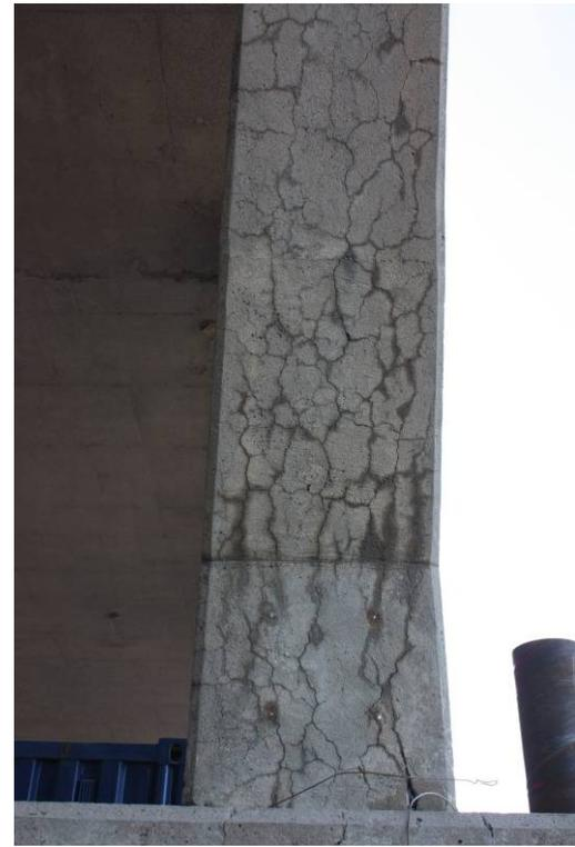
Figure C7 (suite) : Vues rapprochées, colonne Y17 (non traitée). B. Fût, face sud. C. Branche est – face dessus. D. Branche est, face nord. E. Branche ouest, dessous.
