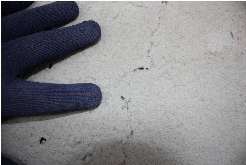
Figure C9 (suite) : F et G : Vues rapprochées de la fissuration, colonne Y23 (traitée avec *Masterseal SL* et enduit *Ambex*).
