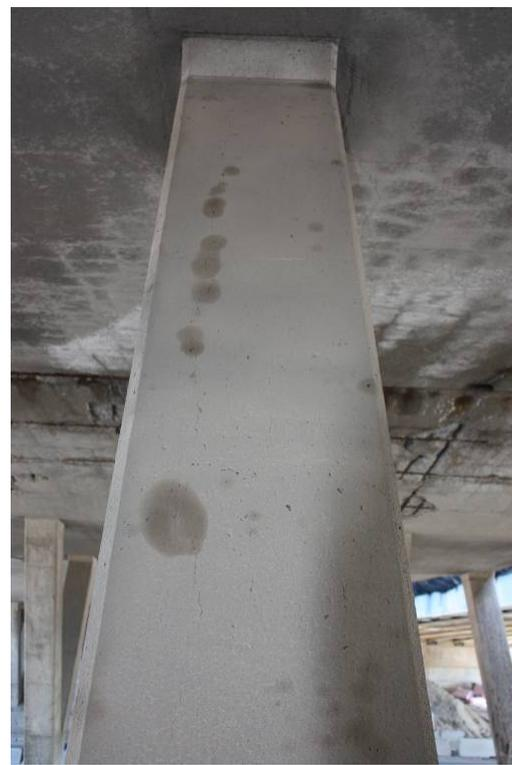
Figure C8 (suite) : Vues rapprochées, colonne Y22 (traitée avec *Masterseal SL* et enduit *Miracote*). B. Fût, face sud. C. Branche est – dessous. D. Branche est, face dessous. E. Branche est, dessous.
