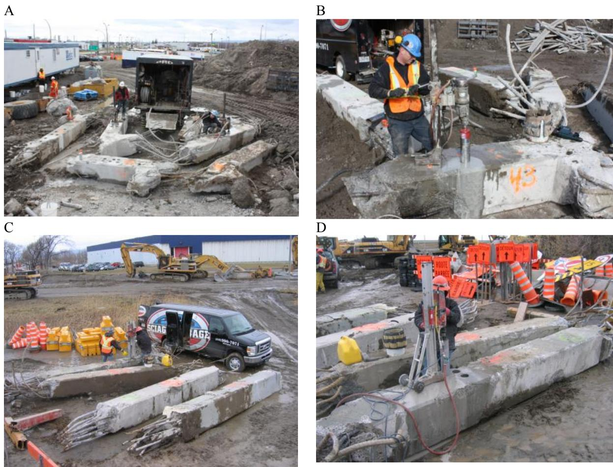
Figure 3.15: Carottage des branches de colonnes en « Y ». A et B: Colonnes de la structure *sud*. C et D: Colonnes de la structure *nord*.
