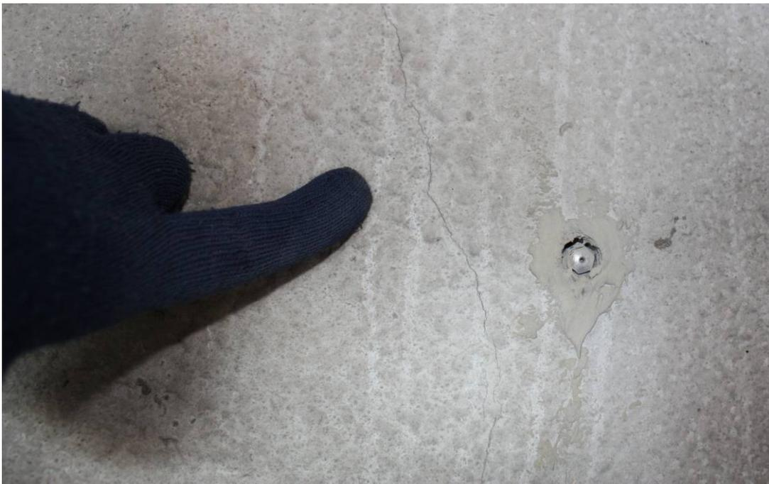
Figure C8 (suite) : colonne Y22 (traitée avec *Masterseal SL* et enduit *Miracote*) : F et G : Vues rapprochées de la fissuration (traitée avec *Masterseal SL* et enduit *Miracote*).
