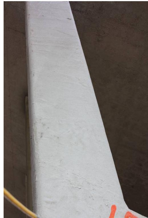
Figure C10 (suite) : Vues rapprochées, colonne Y24 (traitée avec *Sika wrap*). B. Fût, face nord. C. Branche ouest – face dessus. D. Fût, face est. E. Branche ouest, face sud.
