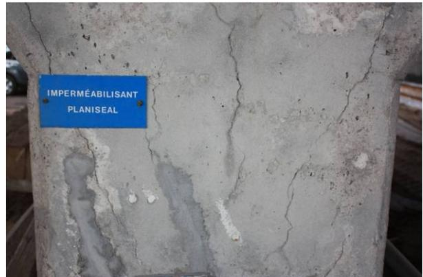
Figure C3 (suite) : Vues rapprochées, colonne Y29 (traitée avec *Planiseal*). B. Fût, face sud. C. Branche est – face nord. D. Branche ouest, face dessous. E. Fût, face nord.
