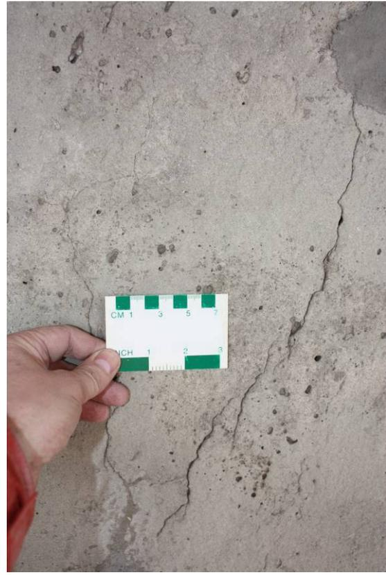
Figure C3 (suite): F et G : Vues rapprochées de la fissuration, colonne Y29 (traitée avec *Planiseal*).
