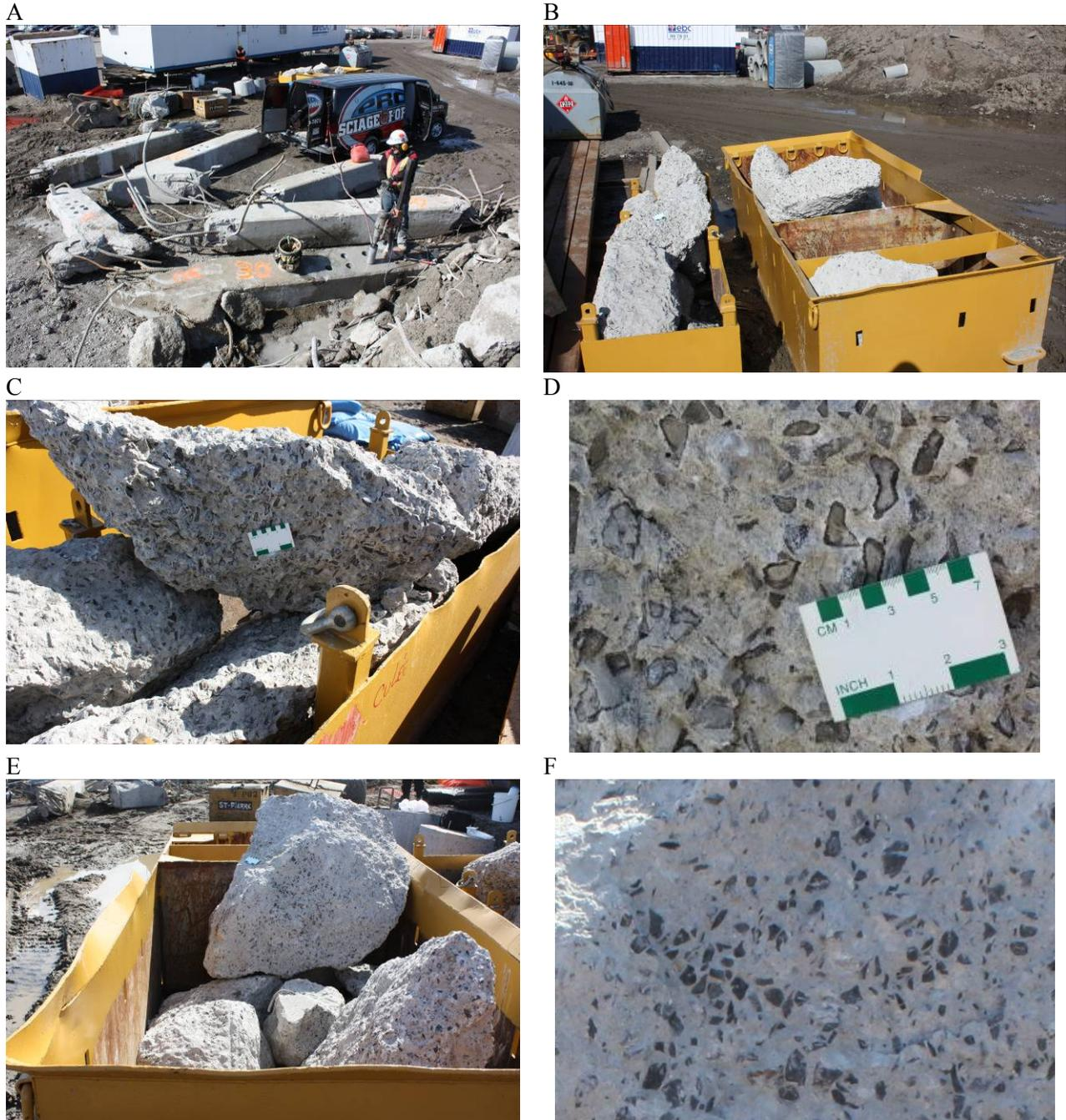
Figure 3.20 : Blocs de démolition de l'échangeur Robert Bourassa – Charest et utilisés pour la fabrication des GBR. A. Sections de colonnes en Y en cours de forage. B. Blocs de démolition prêts à être expédiés pour le concassage dans une carrière de la région de Sherbrooke. C et D. Blocs provenant des bases massives. On remarque des indices typiques et abondants de RAS (produits blanchâtres au niveau des surfaces de fractures de granulats). E et F. Blocs provenant du tablier.
