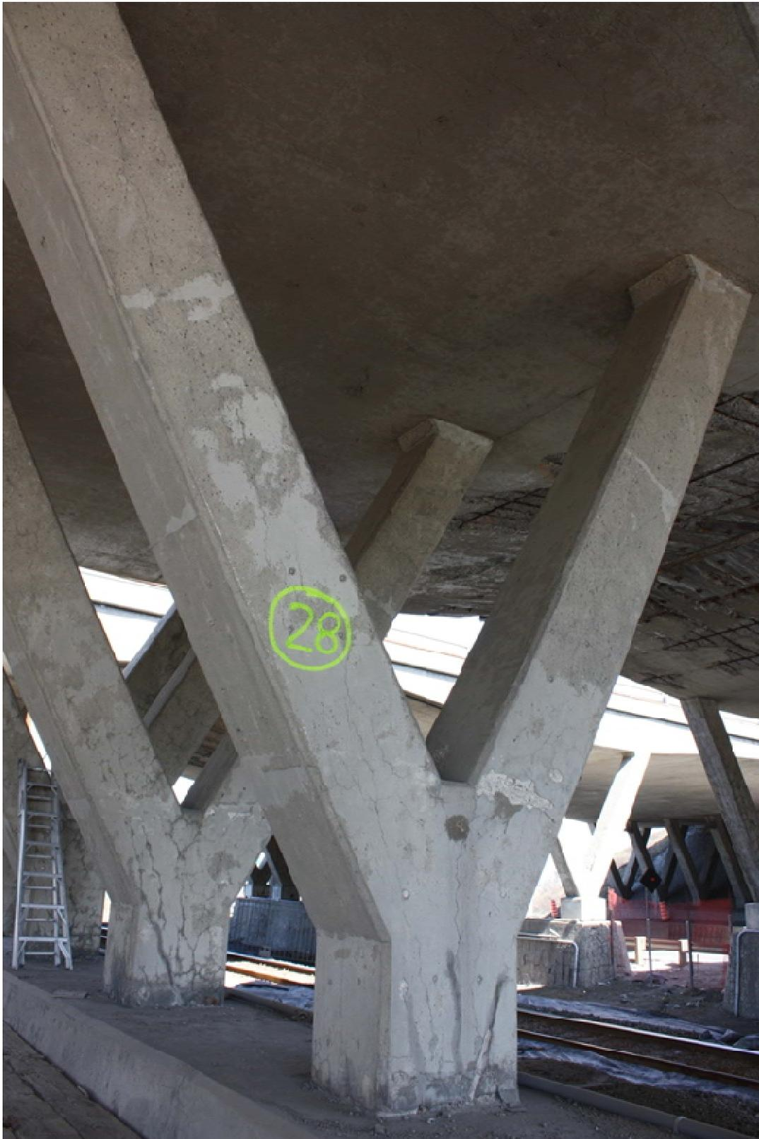
Figure C2 : Vue d'ensemble, colonne Y28 (traitée avec *Masterseal SL*)
