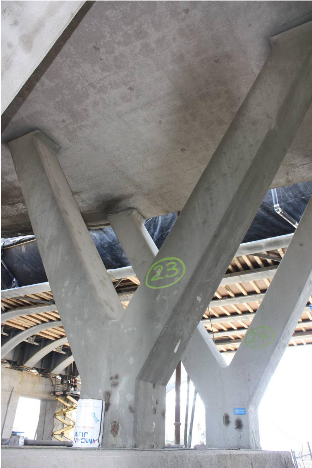
Figure C9: Vue d'ensemble, colonne Y23 (traitée avec *Masterseal SL* et enduit *Ambex*).
