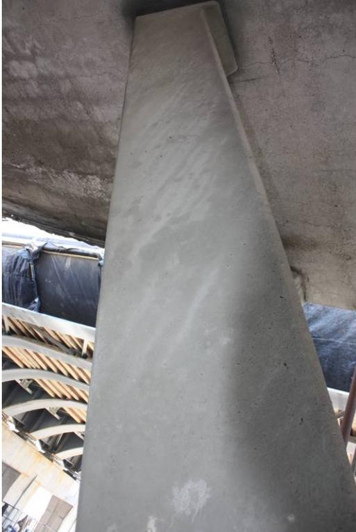
Figure C9 : Vues rapprochées, colonne Y23 (traitée avec *Masterseal SL* et enduit *Ambex*). B. Fût, face sud. C. Branche ouest – face sud. D. Branche est, face dessus. E. Branche est, face sud.
