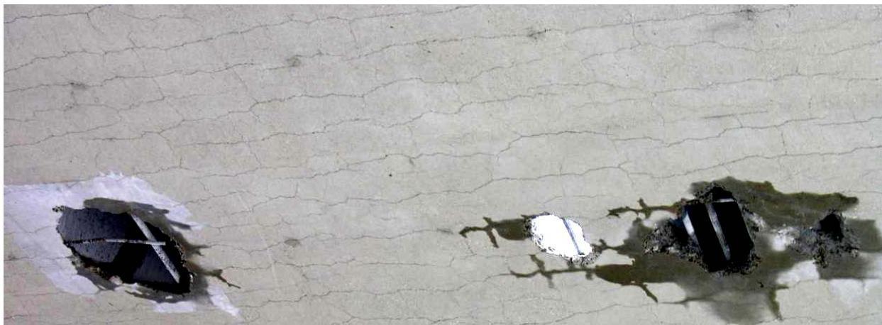
Figure 4.50. Condition et échantillonnage du tablier de l'échangeur Robert-Bourassa – Charest. A. Fissuration sévère dans le côté du tablier de la structure *sud*. B & C. Carottage dans le tablier de la structure *nord* de l'échangeur Robert Bourassa-Charest. D. Fissuration transversale sous le tablier de la structure *nord*; vue à partir de la voie de service située à l'ouest de la voie ferrée et du boulevard Robert-Bourassa.
