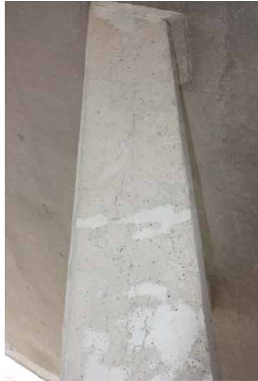
Figure C2 (suite): Vues rapprochées, colonne Y28 (traitée avec *Masterseal SL*) . B. Fût, face sud. C. Branche est – dessus. D. Fût, face ouest. E. Branche est, face sud.
