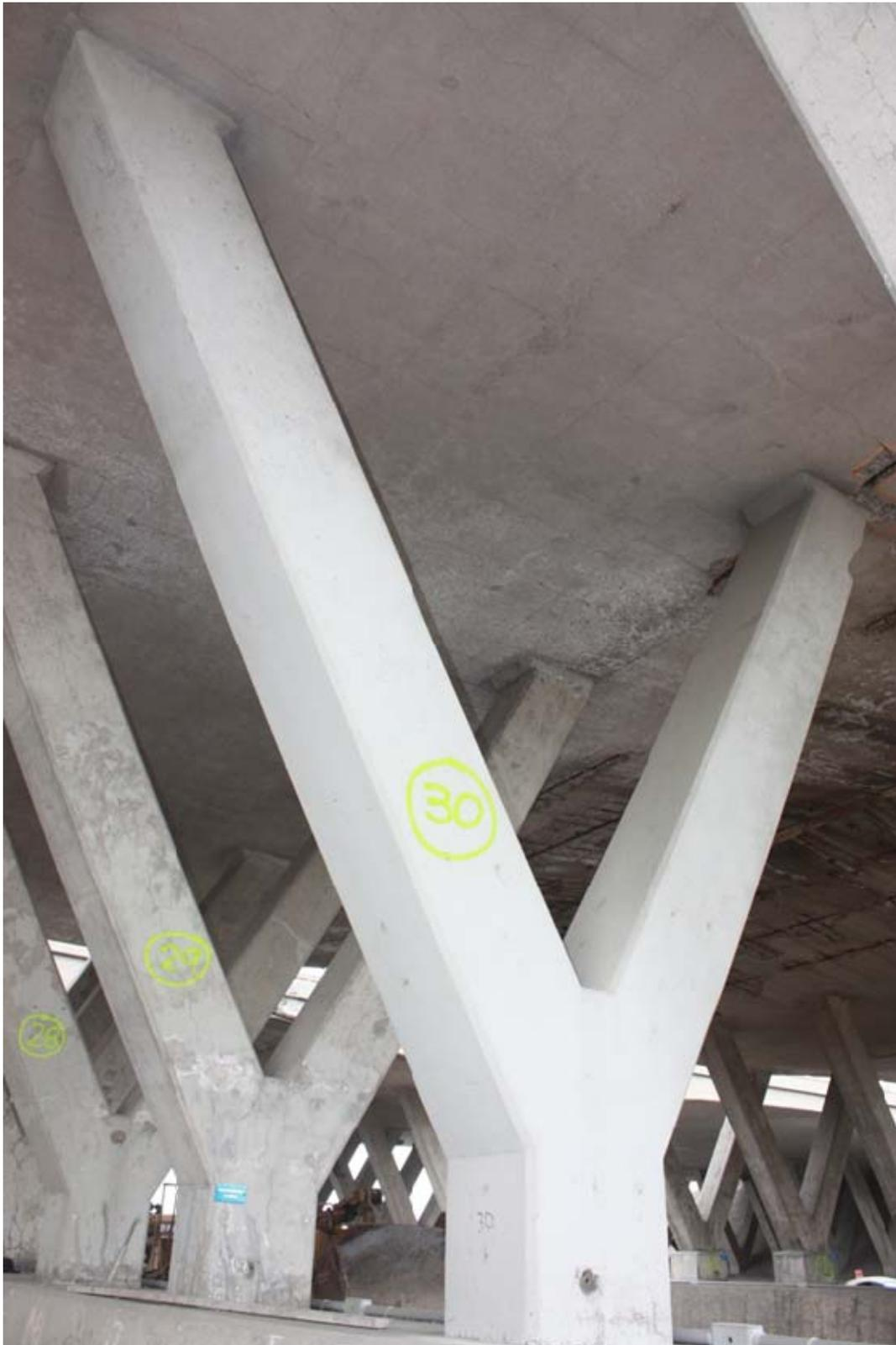
Figure C4 : Vue d'ensemble, colonne Y30 (traitée avec *Masterseal SL* et enduit *Texcote*).
