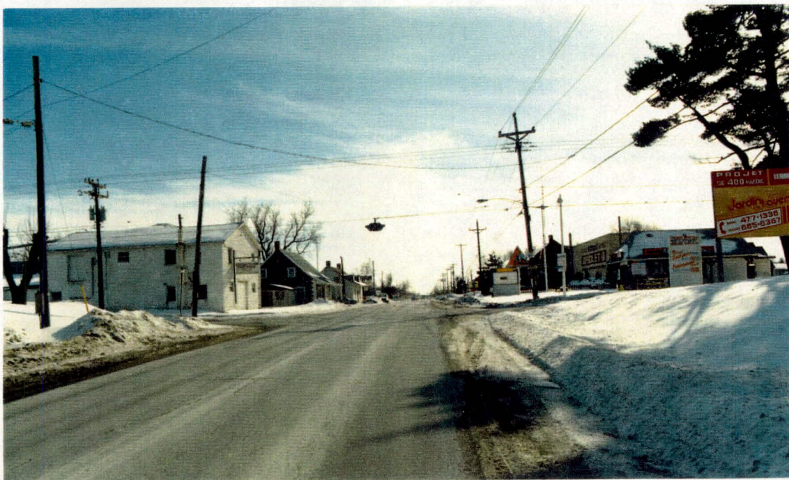
Figure 6 - Unité stylistique et gabarit similaire des édifices à caractère patrimonial.
