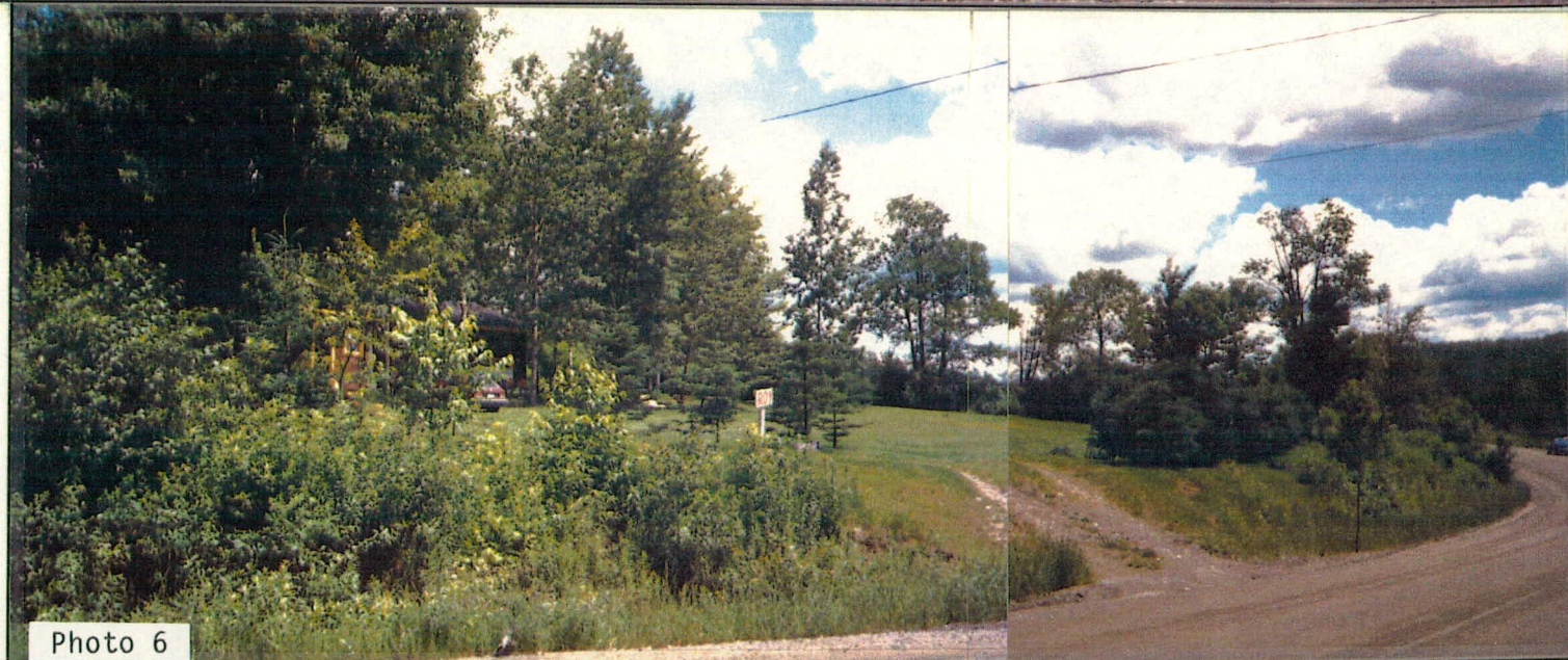
Photos 5 et 6: CH 9+480 à 9+550 (impacts H-13, H-14, V-6). Correction de la courbe vers la fin du projet. Vues en amont (photo 5) et en aval (photo 6) de la courbe.
