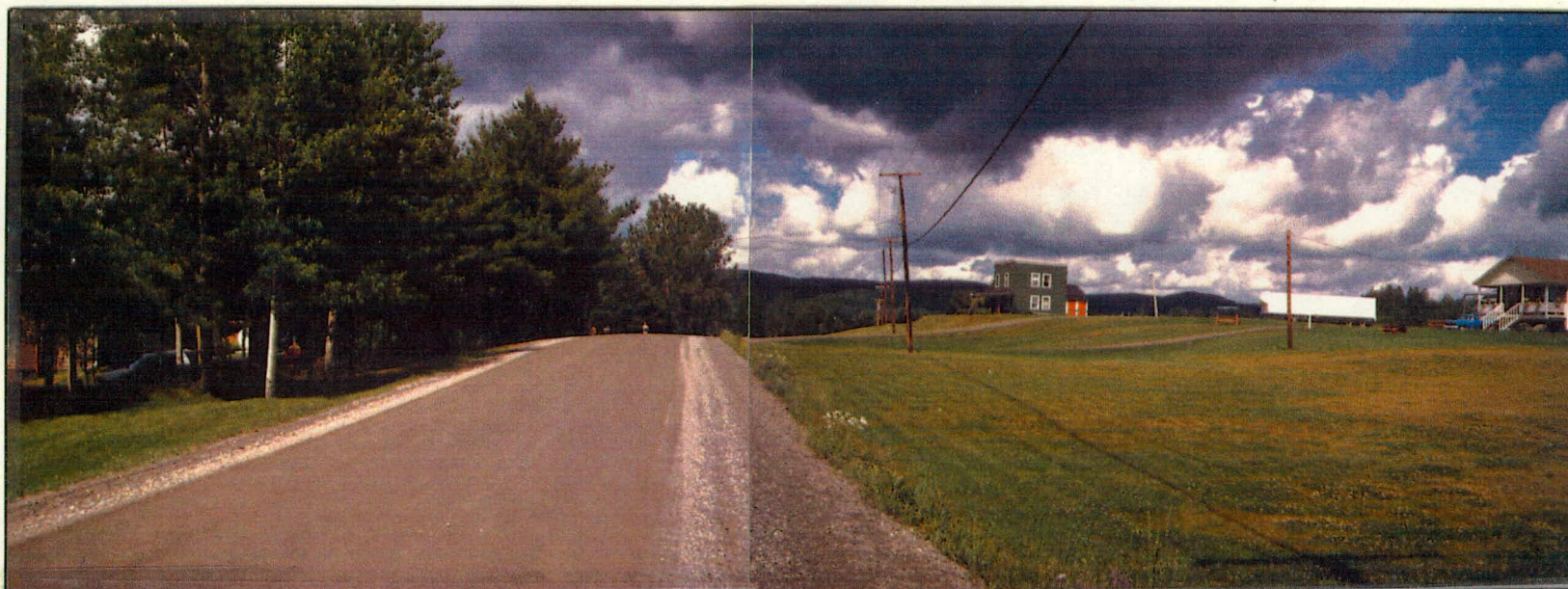
Photo 1: Du CH 6+800 à 6+900 (impacts H-3 et H-4). Correction de la courbe au début du projet. Du côté gauche, chalets en bordure du lac. Du côté droit, maison à exproprier.
