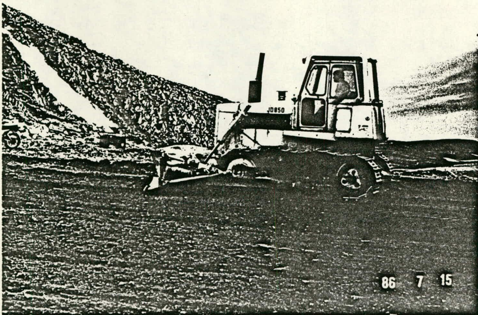
Figure 16 Site E-1986. Préparation du terrain au béliier mécanique (86-7-15).
