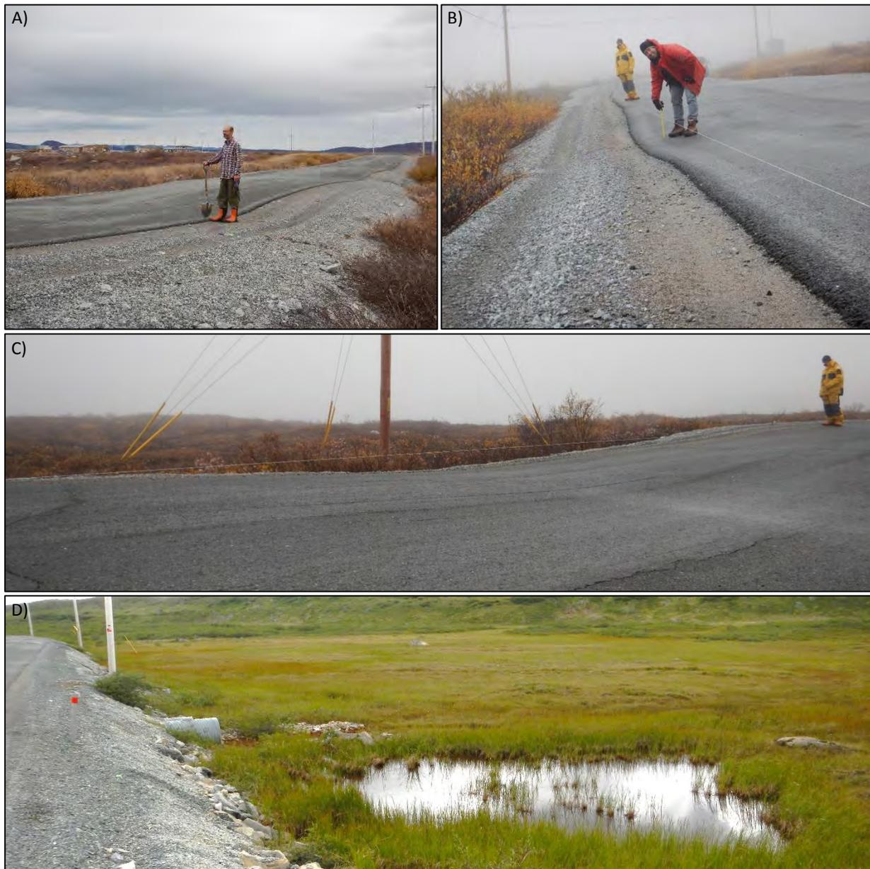
Figure 5: A) Recensement des dépressions importantes qui affectent la route. B) et C) Caractérisation des dépressions observées le long de la route (profondeur et longueur). D) Accumulation d'eau aux abords d'un ponceau.
