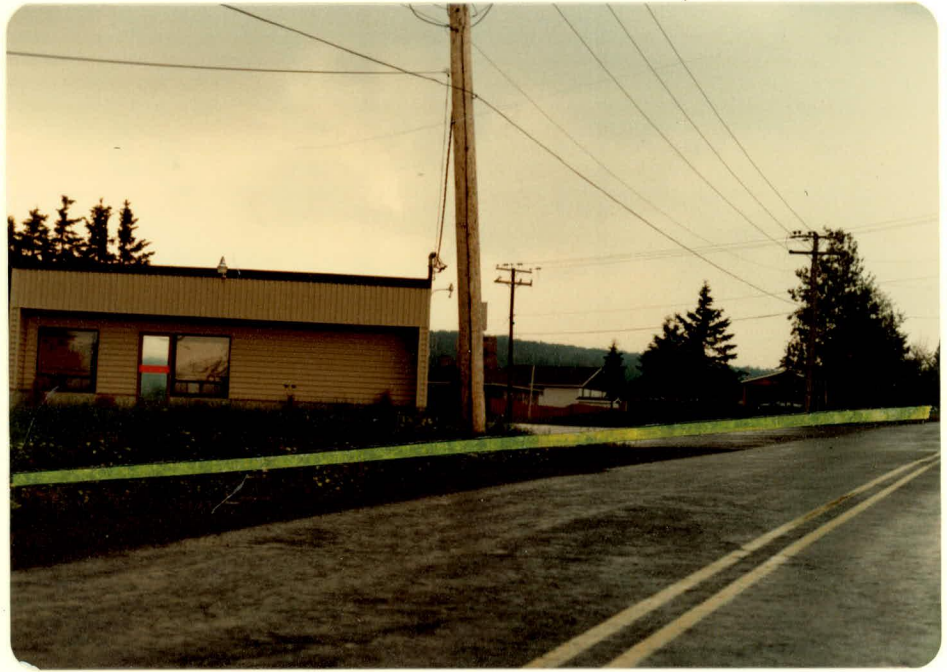
PHOTOS 26 & 27: Route Bernard, vers le chemin St-Charles.
