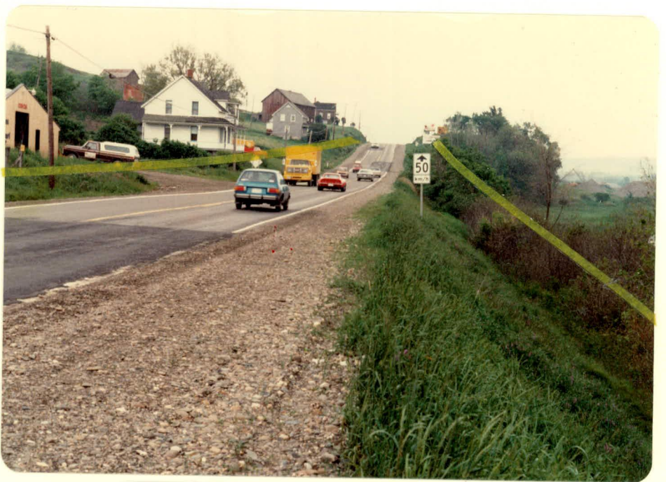
PHOTO 33: Route 173, vers Saint-Georges. A droite, la zone où seraient installés les murs de protection des berges.
