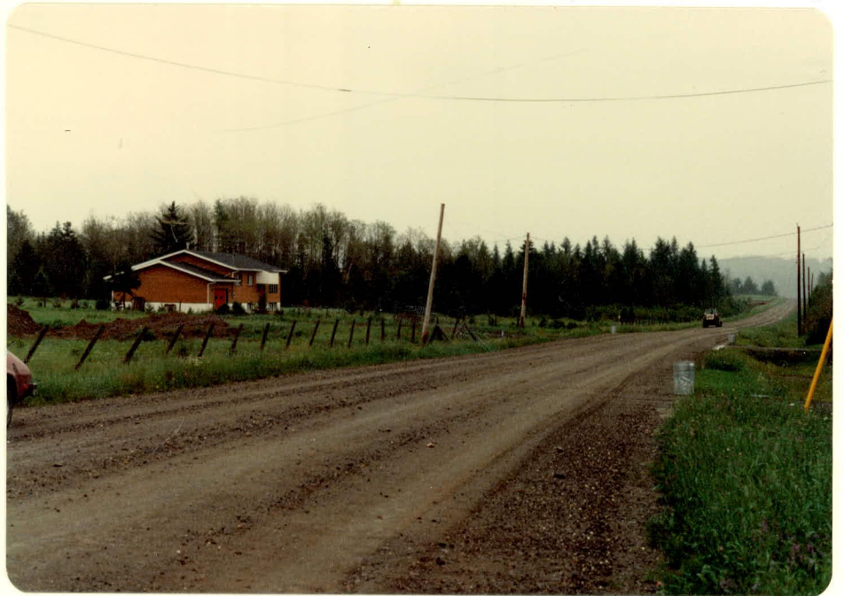
PHOTO 7: Chemin du 2 e Rang, vers le sud-est. L'emprise sera élargie dans ce secteur afin de donner accès à l'autoroute.
