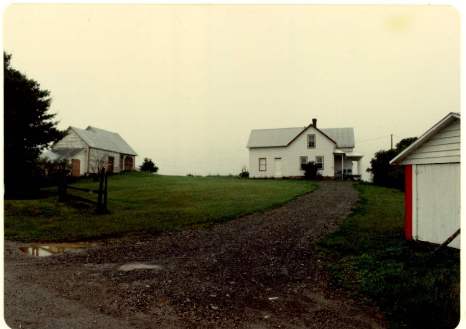
PHOTO 17: Chemin St-Charles, vers le nord-est. Maison située dans les limites de l'emprise de l'autoroute à l'endroit où cette dernière traverse le chemin St-Charles.
