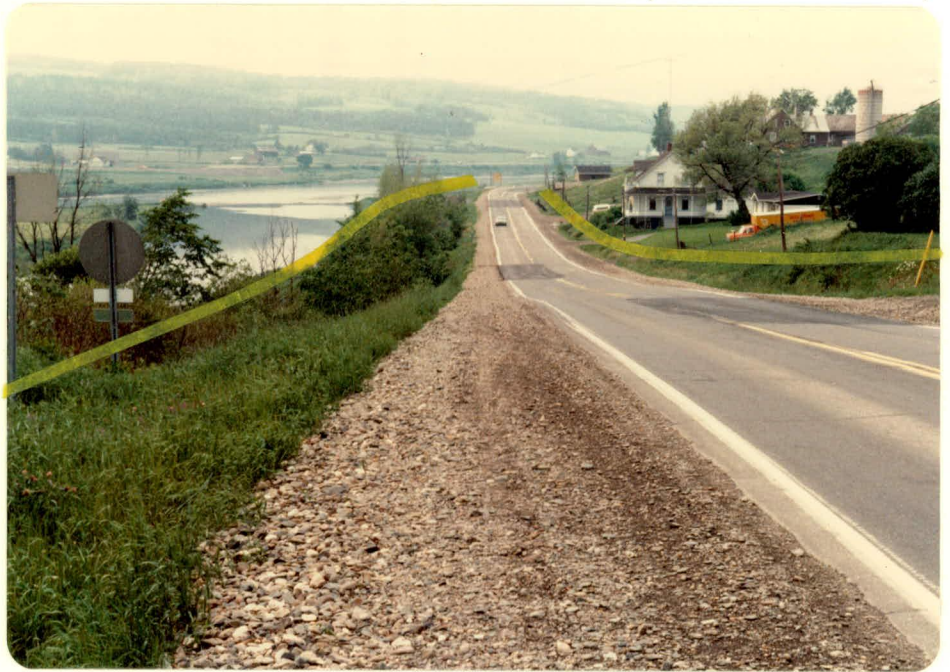
PHOTO 32: Route 173, vers Notre-Dame-des-Pins. A l'avant-plan, à gauche, on installerait des murs en béton.
