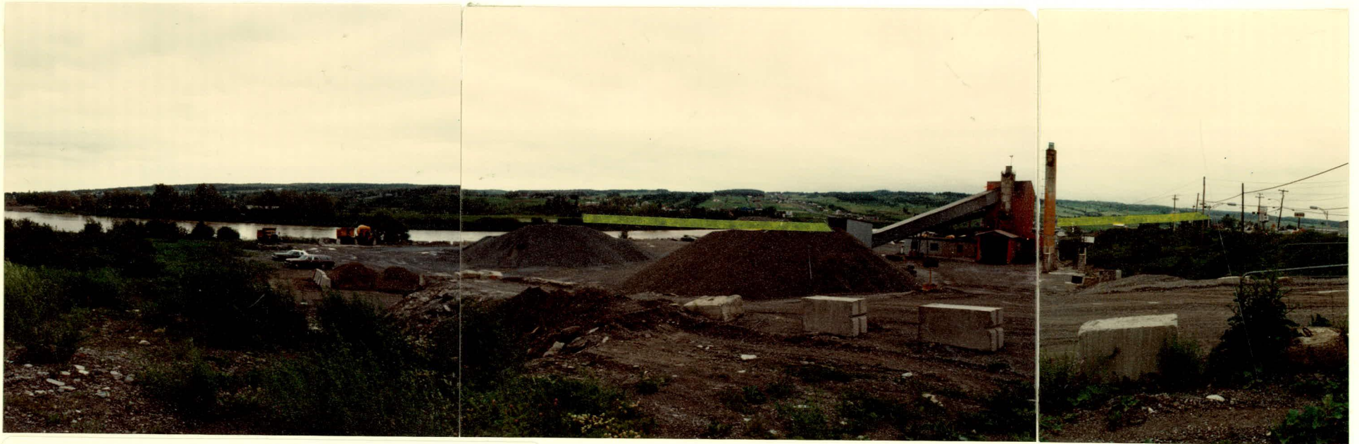
PHOTO 13: Plaine de débordement à l'entrée de Saint-Georges. A l'extrême gauche, on distingue Saint-Georges ouest ainsi que l'embouchure de la rivière Famine. Cette plaine de débordement constituerait le site de l'échangeur de l'autoroute 73 avec la route 173.
