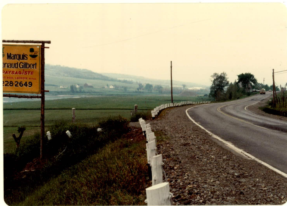
PHOTO 34: Route 173, vers Notre-Dame-des-Pins. Fin des murs de soutènement.
