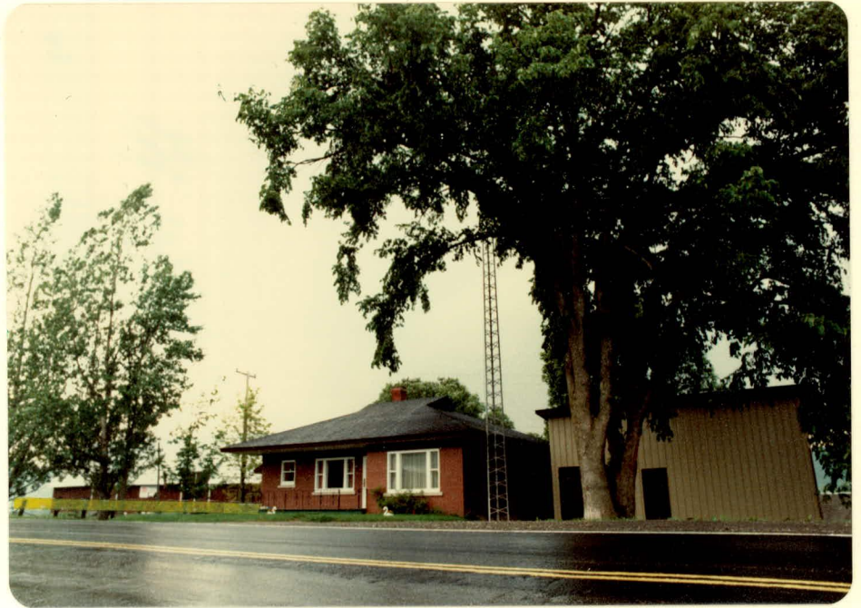
PHOTO 48: Route 173, contournement de Notre-Dame-des-Pins; 2 bâtiments expropriés (vue sud-ouest).
