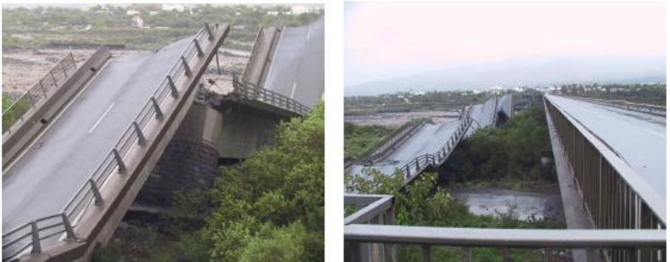
Figure 21 : Photographies d'un pont situé sur la rivière Saint-Étienne à la Réunion qui s'est effondré le 26 février 2007 lors du passage du cyclone Gamède sur la Réunion : ce phénomène s'est accompagné de fortes précipitations qui ont provoqué l'affouillement de certaines piles et la chute successive de plusieurs travées. Source : DDE La Réunion.
