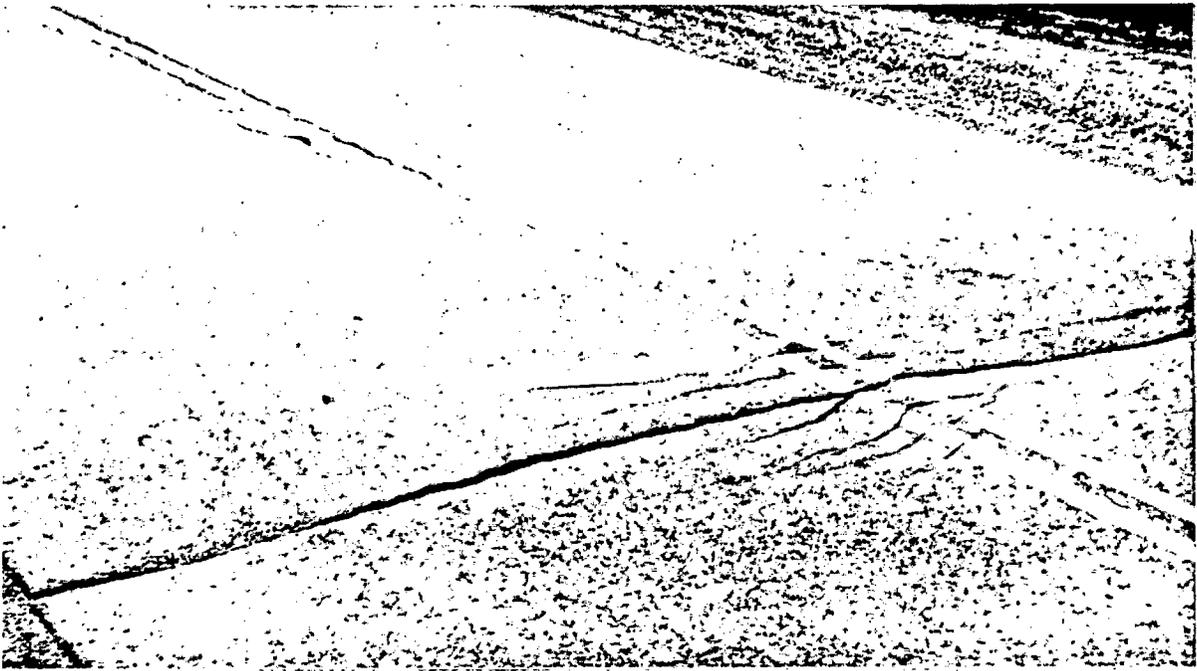
Fig. 2 Fissure transversale
