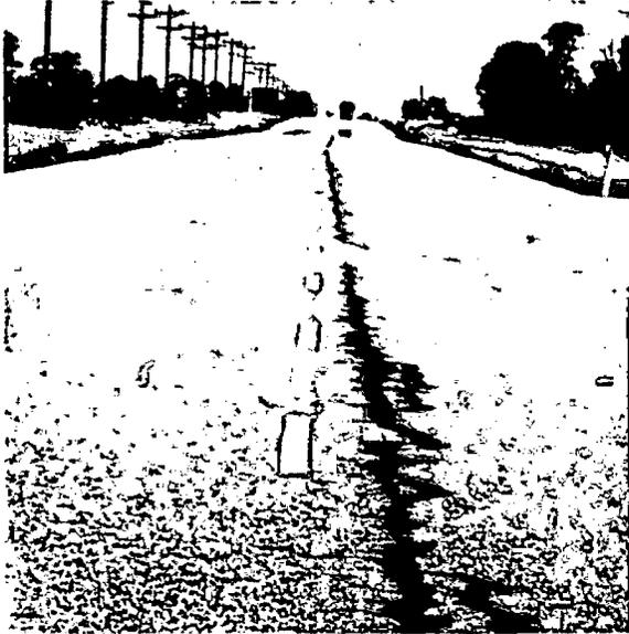
Fig. 3 Fissure longitudinale
