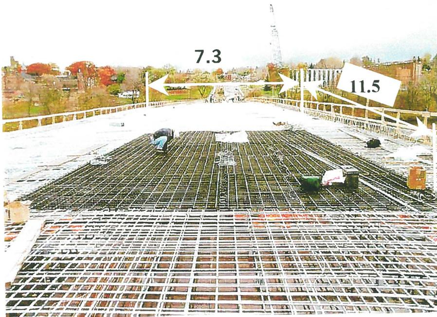
Figure 10. Vue générale des treillis Nefmac placés dans la dalle du tablier du pont Joffre
