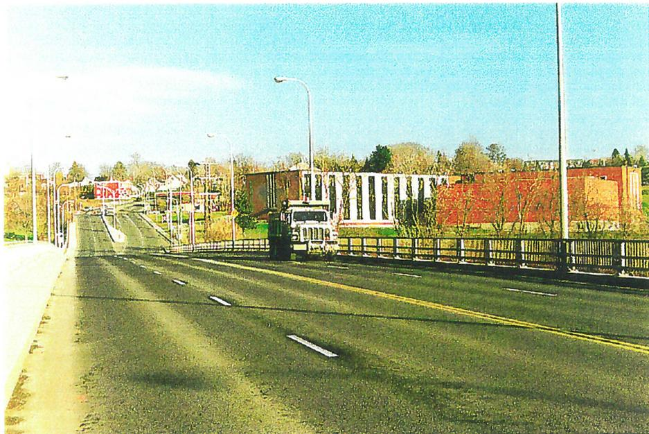
Figure 44 Vue générale d'un camion en mouvement sur le pont Joffre pour les essais de chargement dynamique
