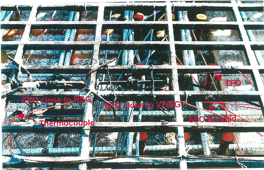
Figure 17. Vue rapprochée de capteurs à fibre optique Fabry-Pérot installés dans la dalle du tablier du pont Joffre avant le coulage du béton
