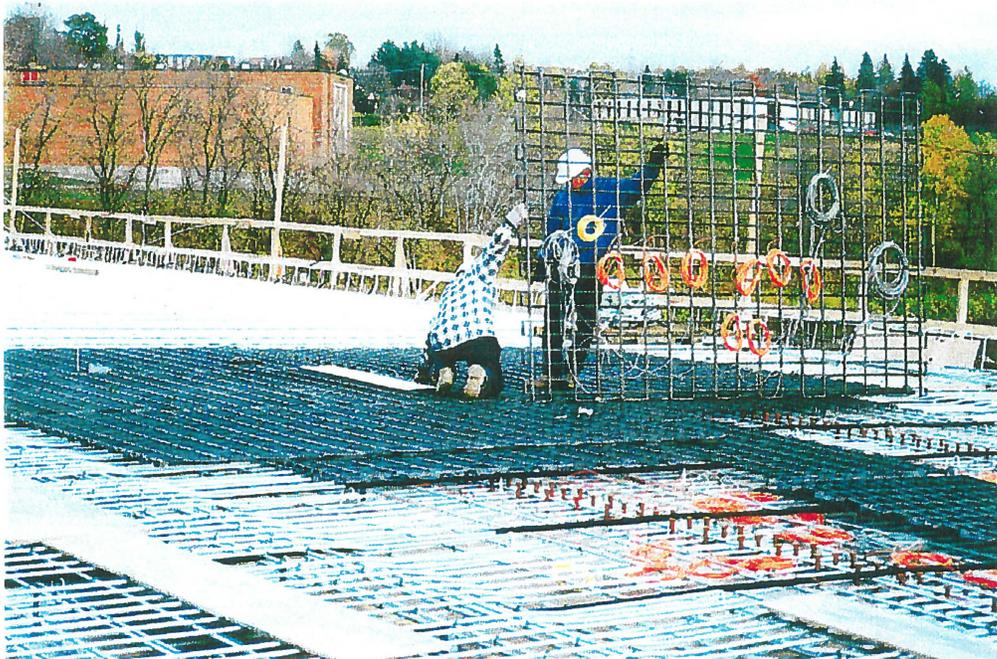
Figure 16. Treillis Nefmac instrumenté durant son installation sur le site (pont Joffre)
