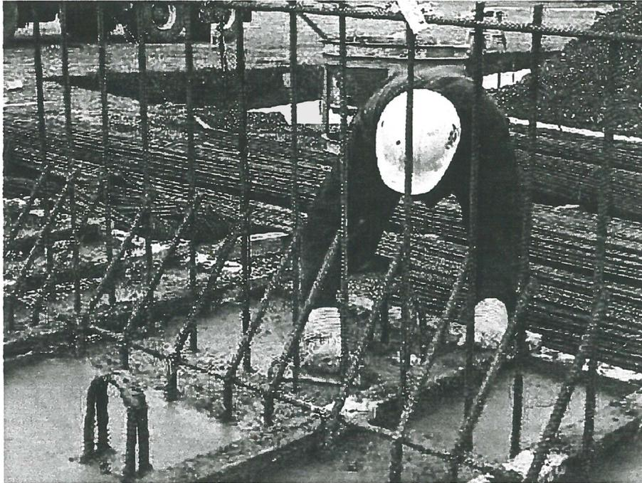
**Figure 5 . Finition de la surface de la dalle d'une glissière (PL3-Acier)**
