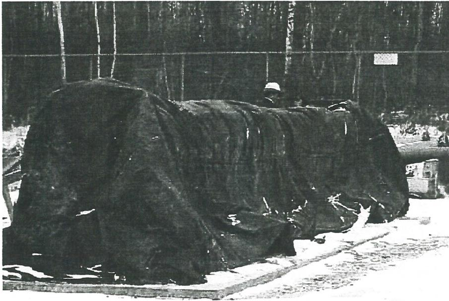
**Figure 11 . Vue d'une glissière sous protection thermique (isolants de 2 pouces)**
