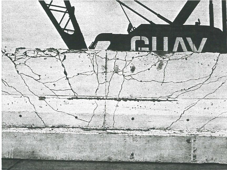
**Figure 47. Fissuration sur la face arrière - glissière PL2-IS2**
