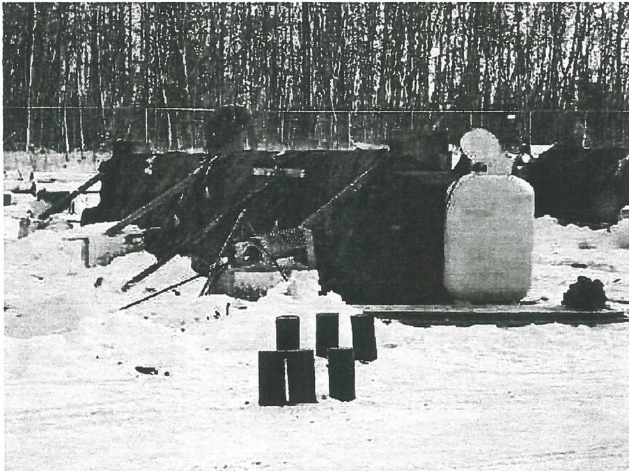
**Figure 12 . Vue d'une glissière sous chauffage thermique au gaz en hiver**
