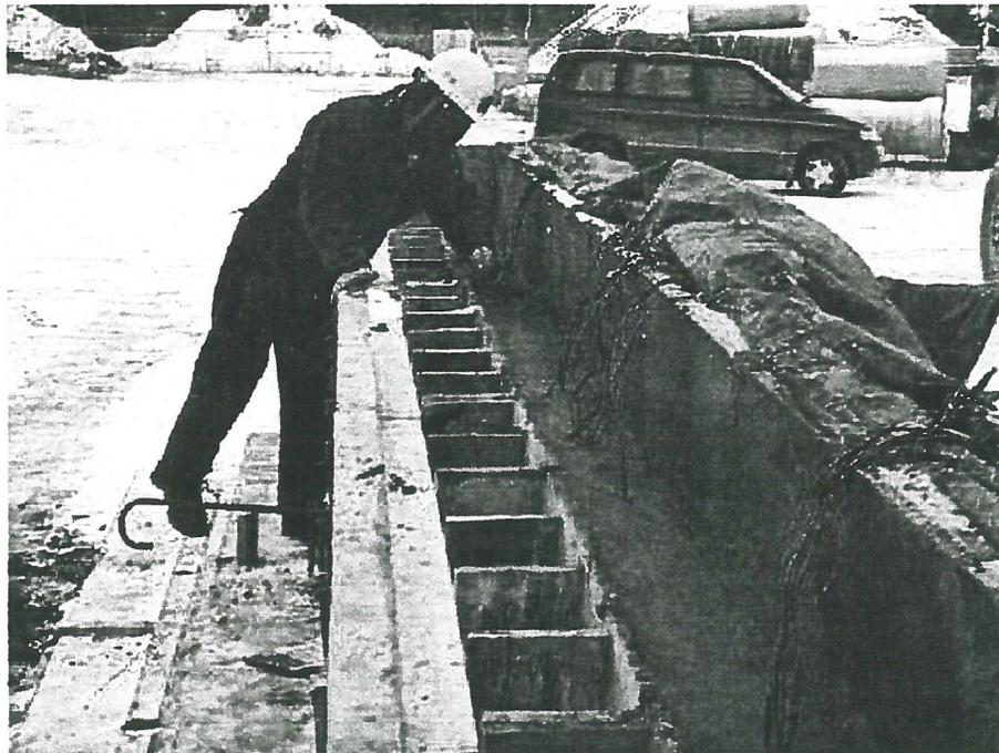
**Figure 8 . Finition du béton de la partie supérieure d'un mur d'une glissière (PL3-IS)**
