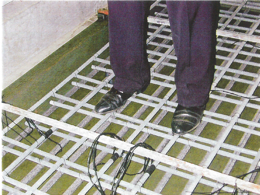
Figure 16 Vue du coffrage d'une dalle avec les 2 nappes d'armature (supérieure et inférieure)
