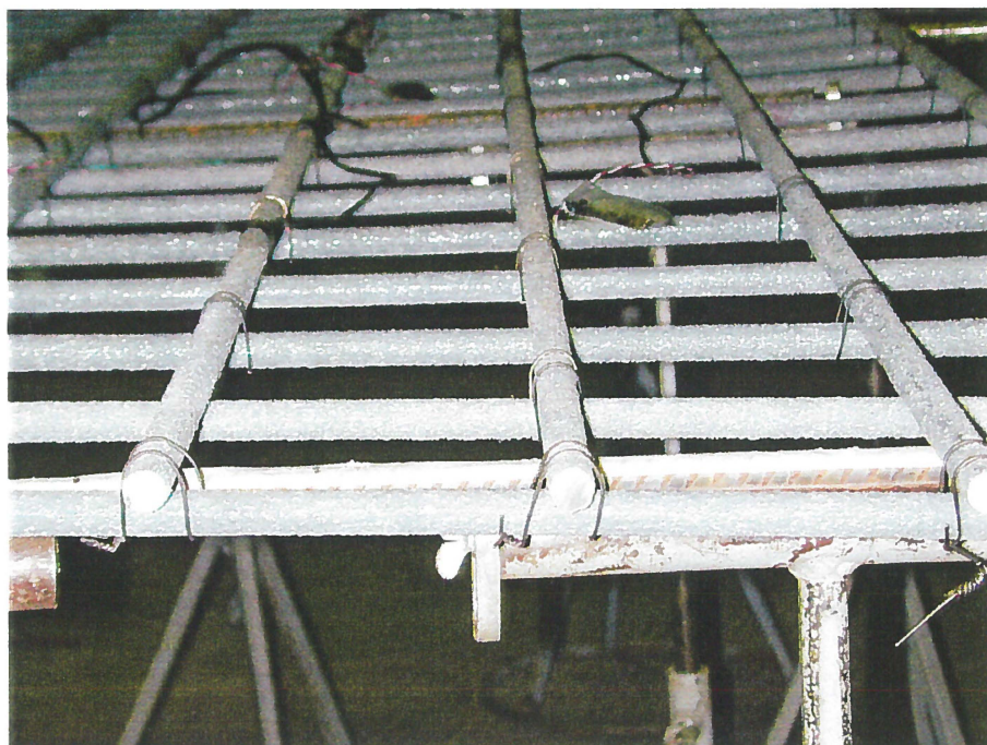
Figure 14 Vue rapprochée de l'armature en matériaux composites (Isorod)
