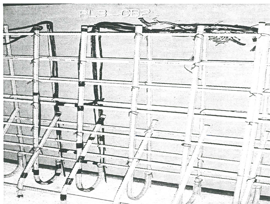
Figure 2.18 Vue rapprochée des armatures de la glissière PL3-CB2
