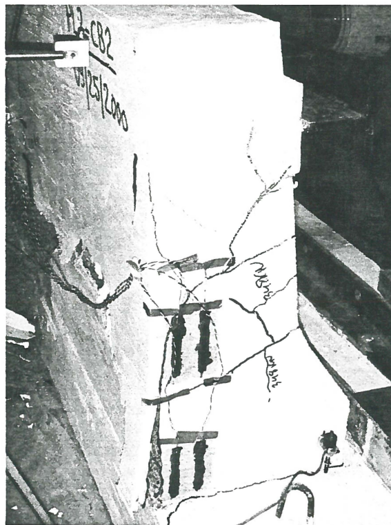
Figure 3.4 Vue rapprochée du mode de rupture type par cisaillement/compression (glissière PL2-CB2)
