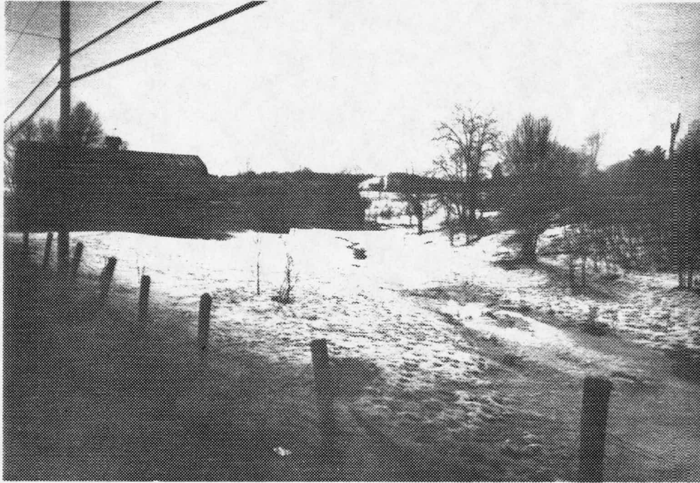
21 Ensemble des bâtiments de ferme à exproprier pour la variante B.
