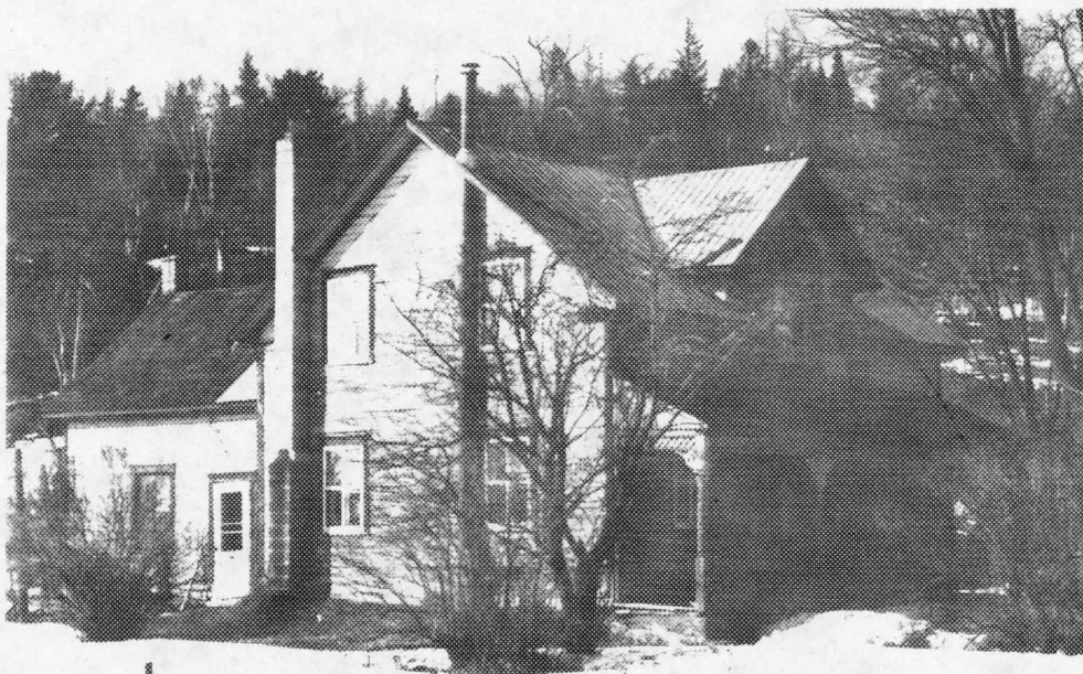
18 Résidence située sur la route 105 à proximité du tronçon ouest de la variante B. Qualité architecturale intégrale.
