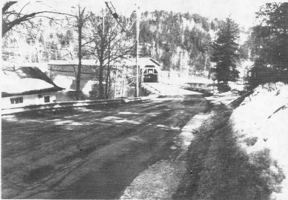
7 Approche sinueuse du pont couvert, côté ouest.
