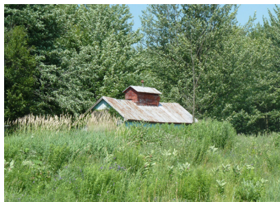
Autres structures agricoles abandonnées
