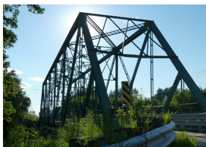
Structures industrielles abandonnées
