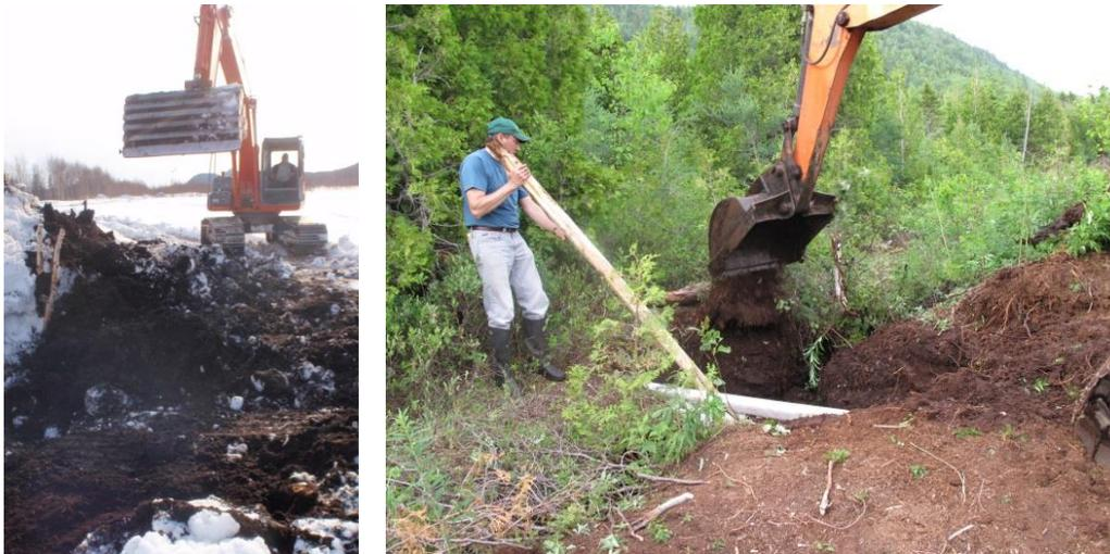
**Figure 10** Rétablissement de l'hydrologie à la tourbière de Bic-Saint-Fabien. À gauche : blocage initial des canaux de drainage en mars 2010. À droite : construction de barrages afin de bloquer l'eau des canaux de drainage en juillet 2010.
