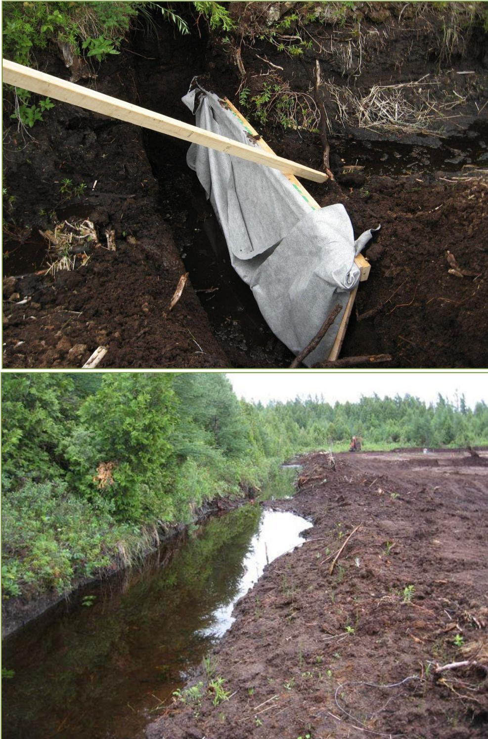
**Figure 7.4 : Blocage du canal de drainage principal adjacent à la partie est de la tourbière de Bic – Saint-Fabien à l'aide de contreplaqué et d'une membrane géotextile (photo du haut), ainsi que le résultat de ces travaux, soit une remontée du niveau de l'eau (photo du bas).**
