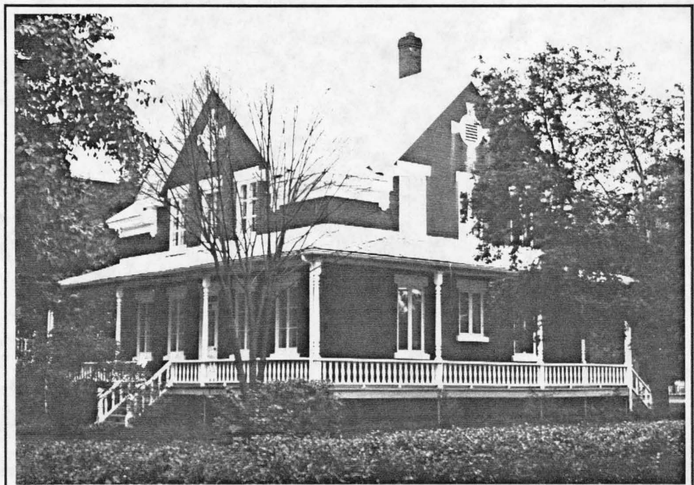
Photo 20: secteur "E", centre du village, angle ouest (B.G., 1990, 03.31)
