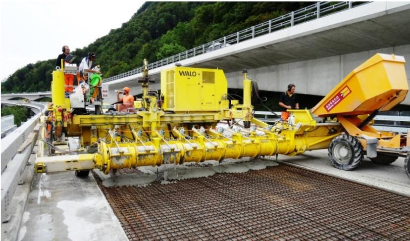
*Renforcement du Viaduc de Chillon au moyen de BFUP armé (août 2014)*
