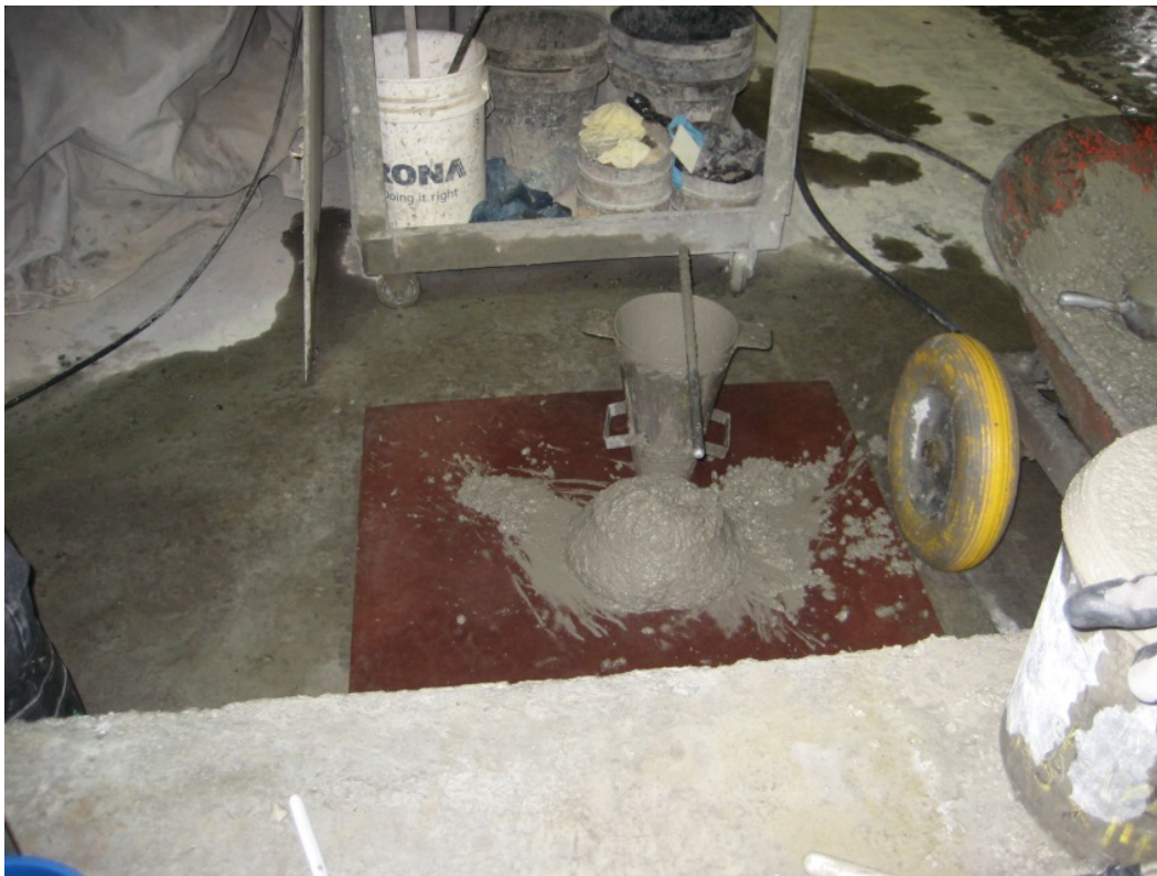
Photo 1 : Mesure des caractéristiques du béton : Affaissement
